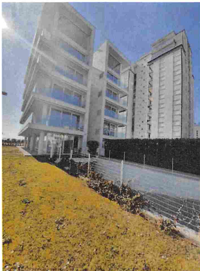
foto n. 5 - vista esterna da via Treviso
