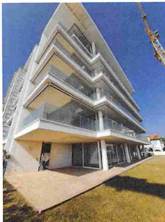
foto n. 6 - vista esterna veranda
