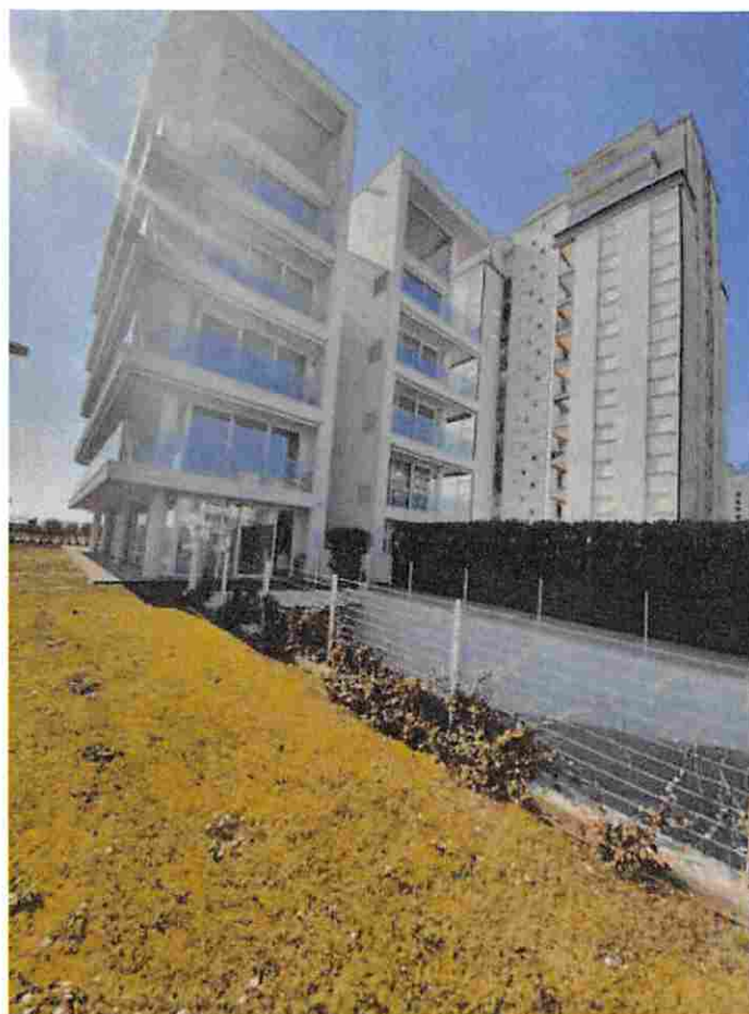
foto n. 5 - vista esterna da via Treviso
