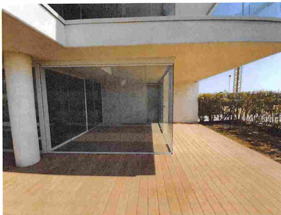
foto n. 6 - vista esterna veranda
