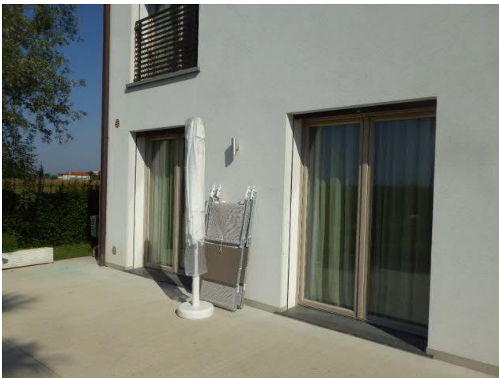
Foto n. 10 – prospetto sud blocchetto magazzino -
