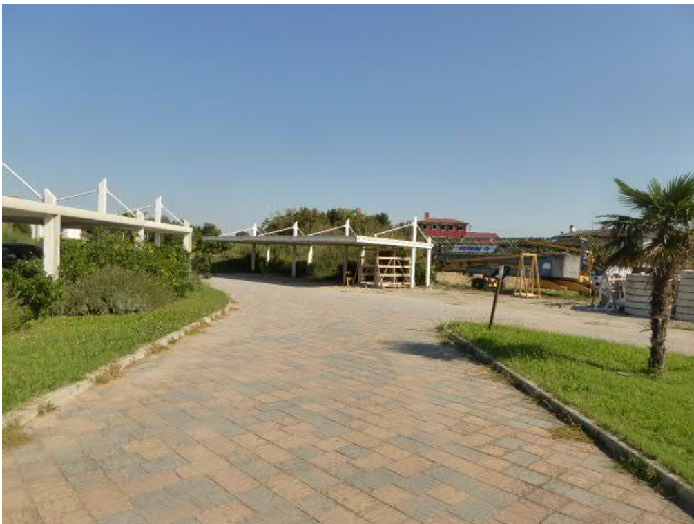
Foto n. 2 – esterno nord tettoie -
