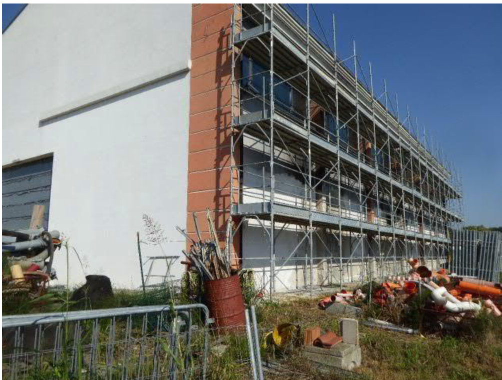
Foto n. 6 – esterno prospetto est -
