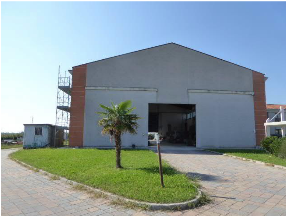
Foto n. 4 – esterno prospetto nord capannone -
