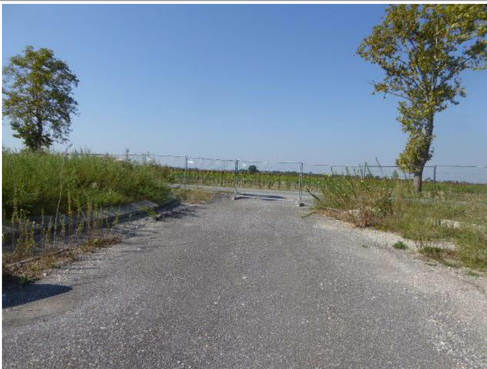
Foto n. 5 – vista interno area oggetto di lottizzazione -
