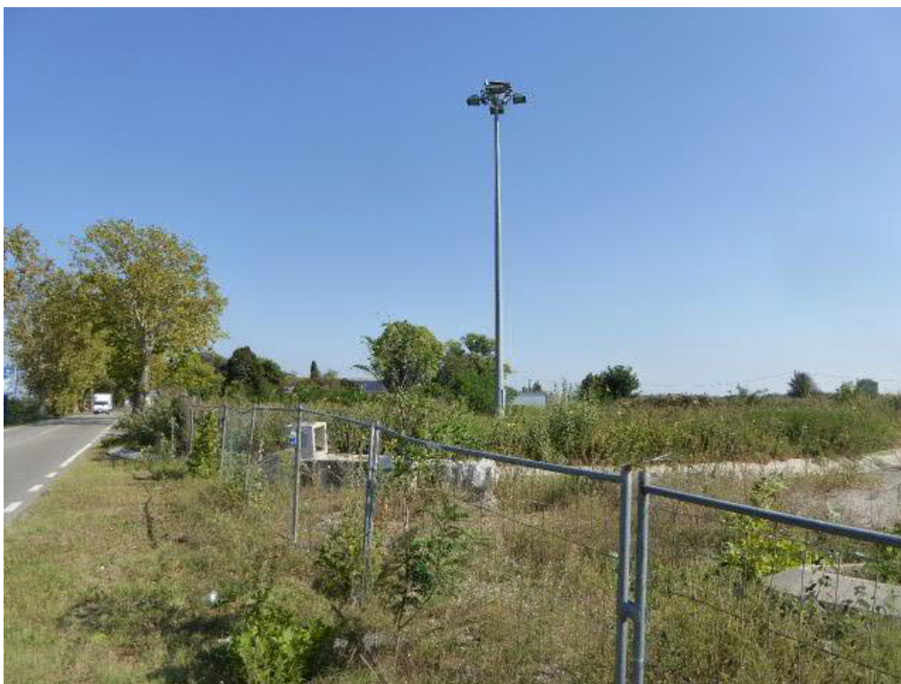
Foto n. 4 – rotonda e impianti in corso d'opera -
