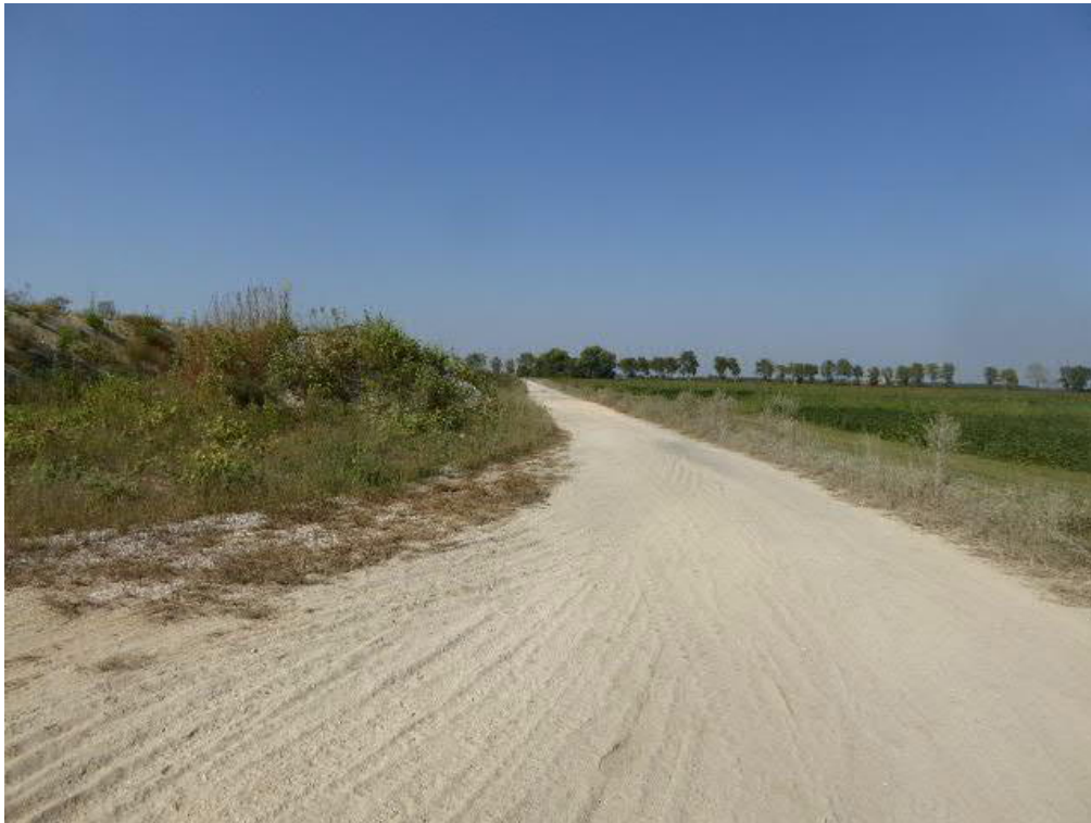
Foto n. 13 – vista interno area oggetto di lottizzazione -
