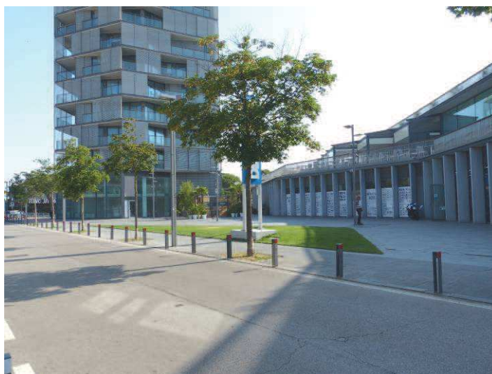
Foto 2 – vista dalla strada
