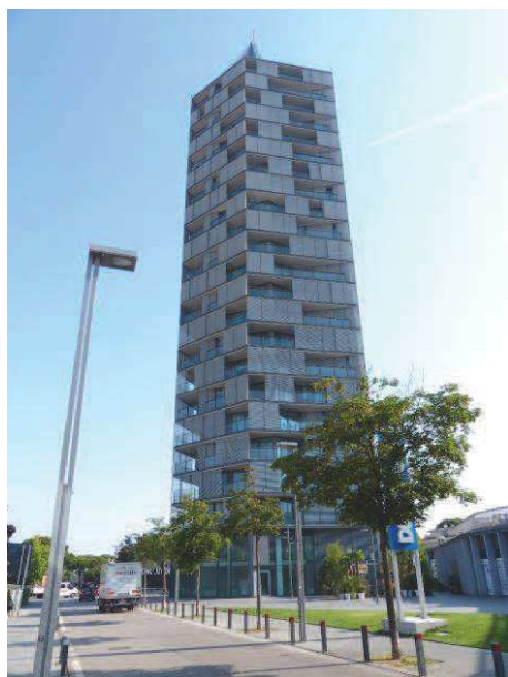
Foto 1 – vista dalla strada
