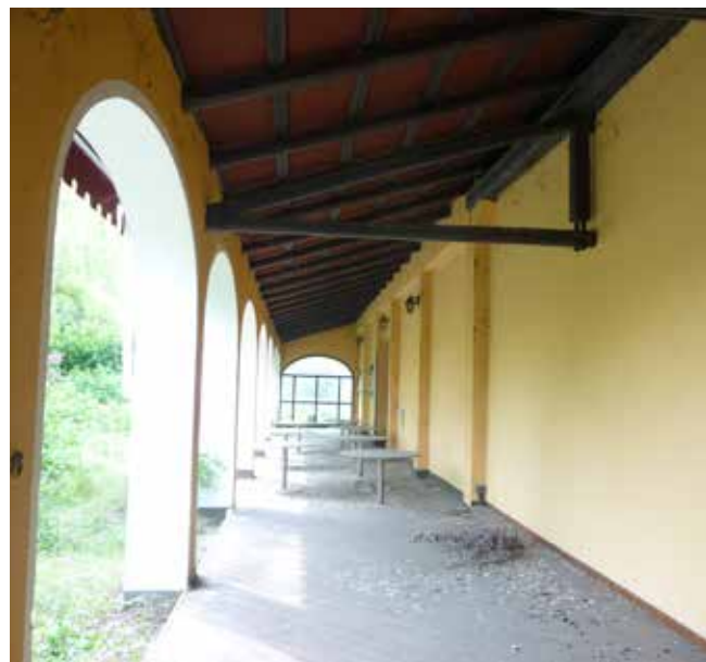
Vista portico lato Sud
