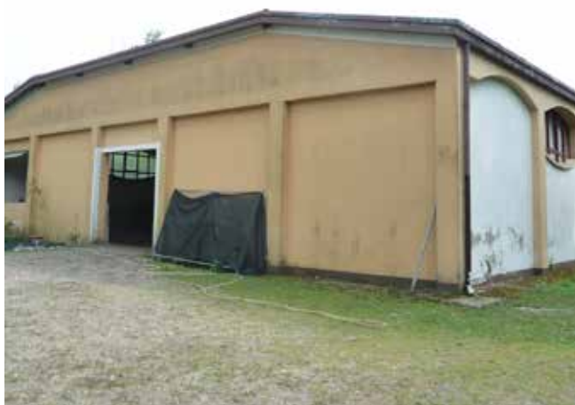
Edificio ad uso maneggio
