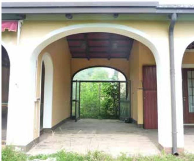
Portico di collegamento alloggi e maneggio
