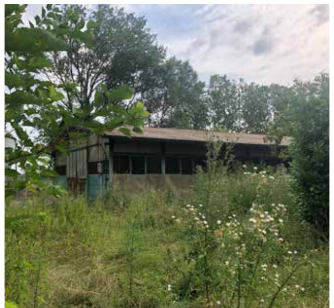
Prospetto scuderia lato Sud
