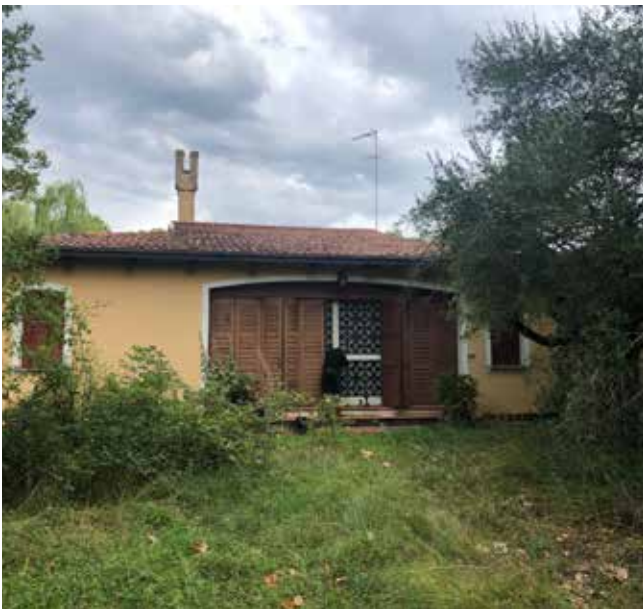
Prospetto Est su via Colombara
