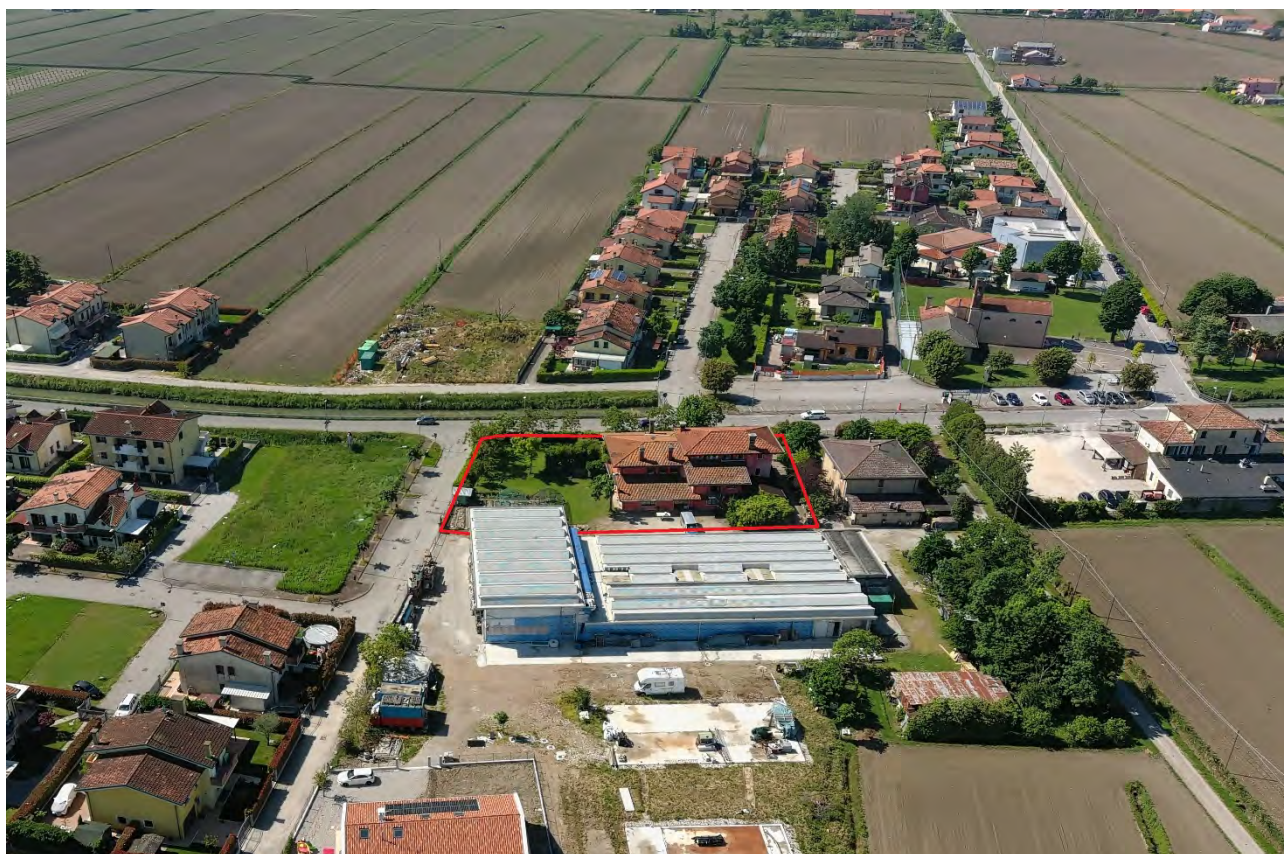
Vista aerea lato nord
