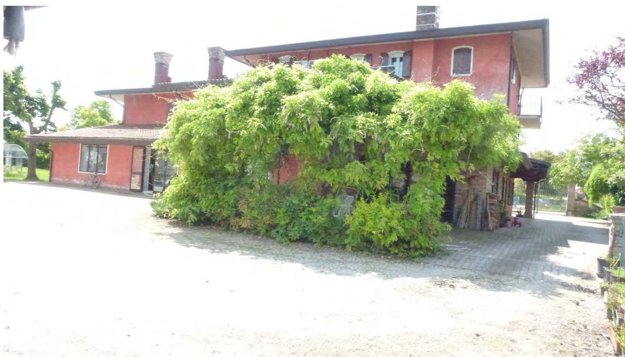
Vista lato Nord
