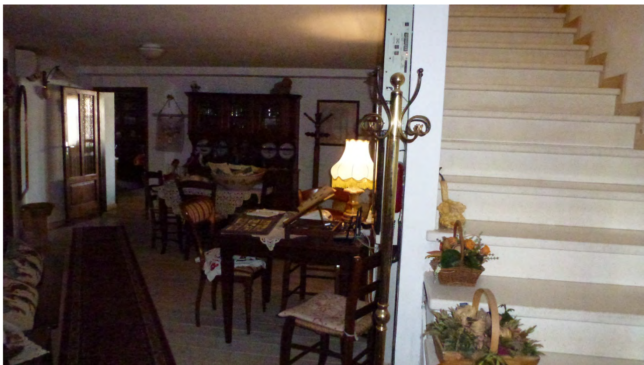
Ingresso piano terra, parete sulla sinistra non regolare
