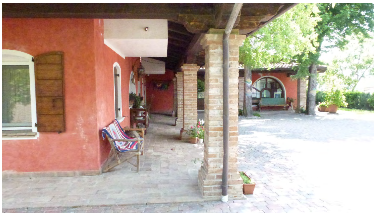
Vista angolo sud ovest
