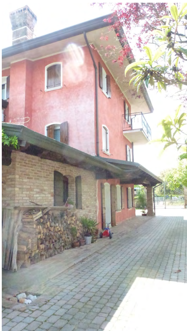
Vista lato ovest
