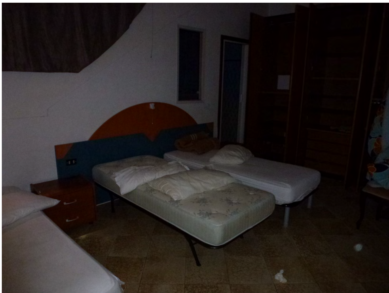
Vista appartamento non regolare ricavato nel negozio
