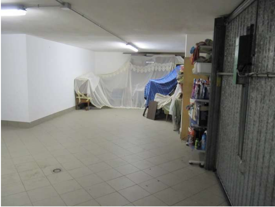
Interno (a destra il basculante elettrificato)
