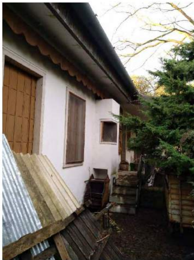
FOTO 10_PROSPETTO EST SUB. 1
