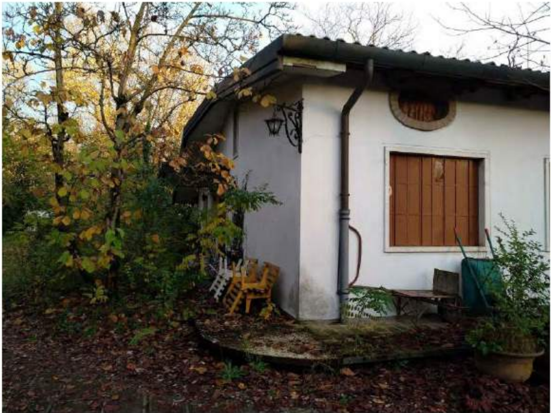
FOTO 7_ANGOLO PROSPETTI NORD ED OVEST SUB. 1
