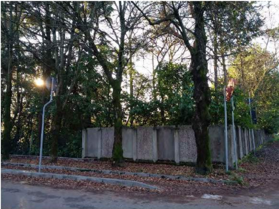
FOTO 3_ANGOLO RECINZIONE EST E SUD
