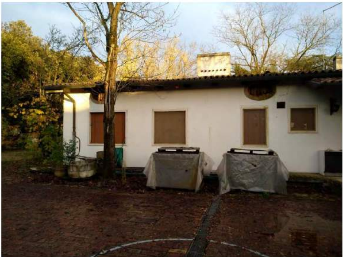
FOTO 6_PROSPETTO OVEST SUB. 1
