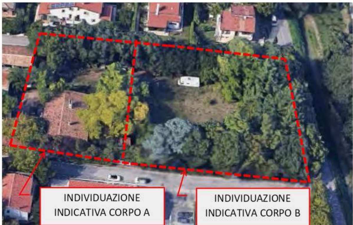
FOTO 1_ IMMAGINE DA GOOGLE MAPS_ VISTA DALL'ALTO DEL COMPENDIO IMMOBILIARE
