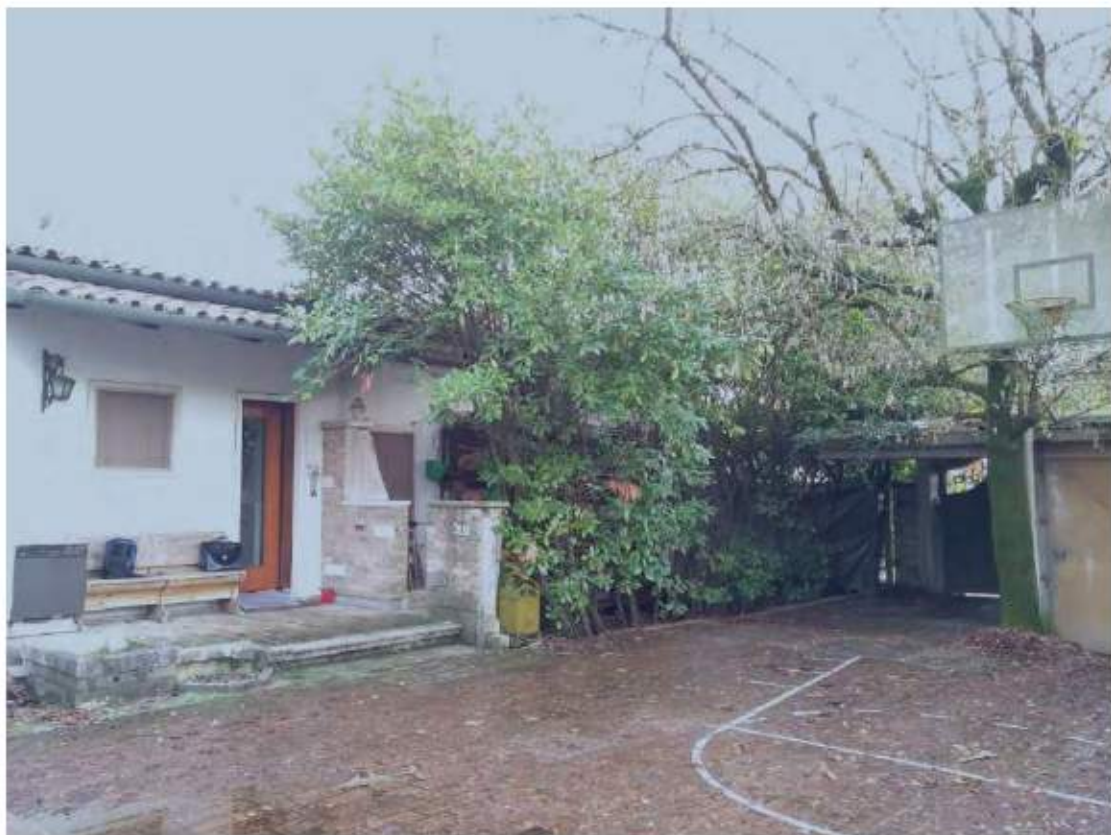
FOTO 4_PROSPETTO OVEST_PARTICOLARE INGRESSO SUB. 1
