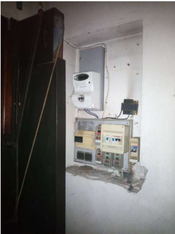
quadro elettrico non a norma
