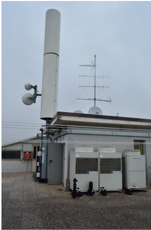
FOTO N. 6 (antenna al piano sottotetto)
