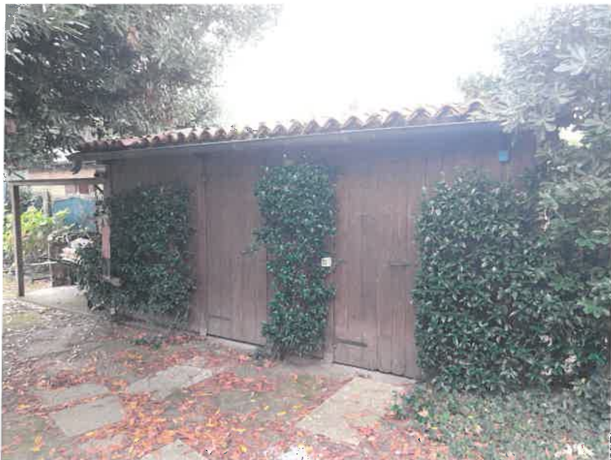
VISTA MAGAZZINO LOTTO 1
