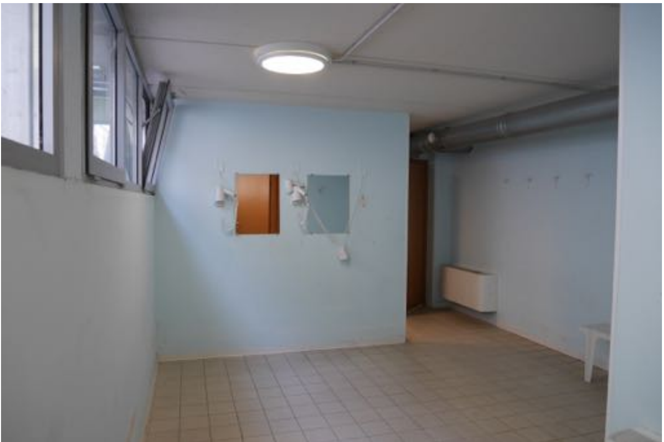
FOTO 10 – Il piano interrato ove si trovano gli spogliatoi e i servizi relativi alla piscina.
