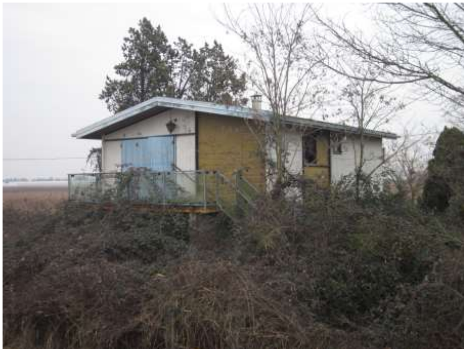
MAPPALE 71 PARTICOLARE ABITAZIONE NON AGIBILE PROSPETTO SUD OVEST
