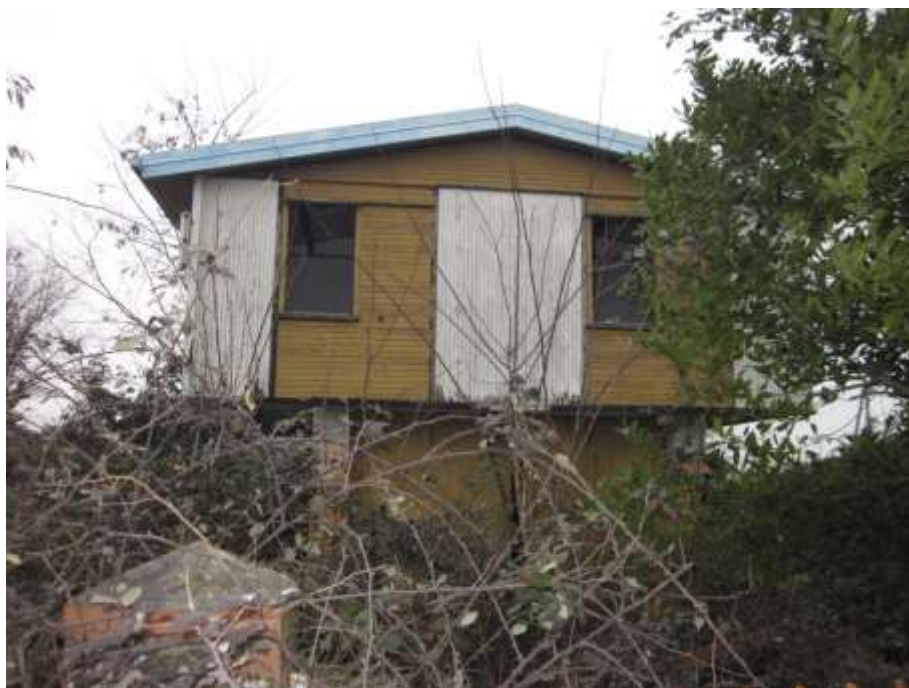
MAPPALE 71 PARTICOLARE ABITAZIONE NON AGIBILE PROSPETTO EST
