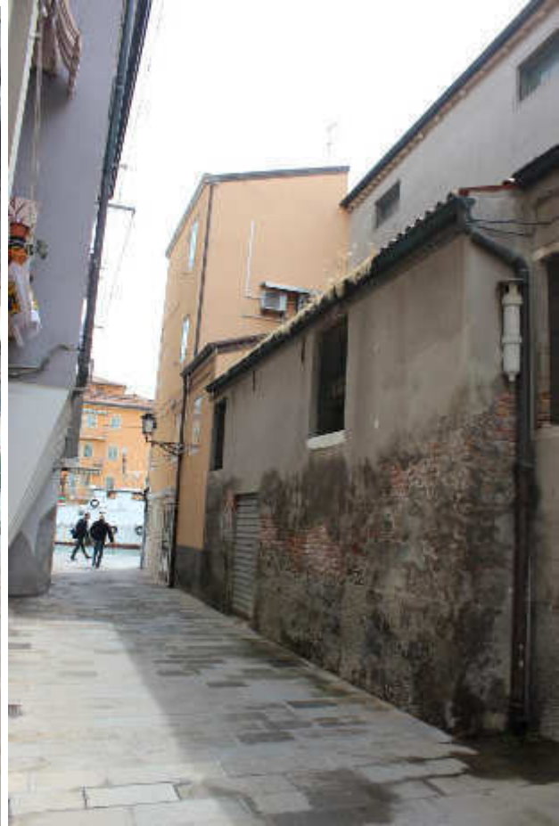
4 vista calle Santa Caterina
