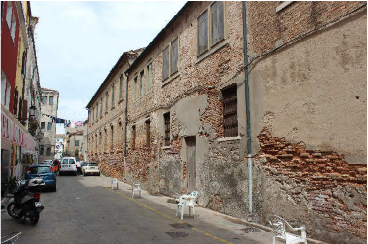
2 fronte calle Forno Filippini
