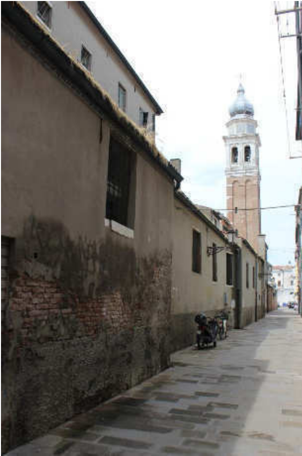
3 vista fronte calle Santa Caterina
