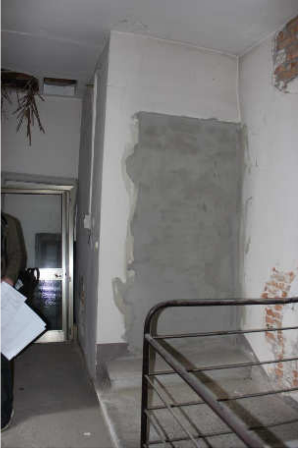
38 porta comunicante con terrazzo chiesa murata
