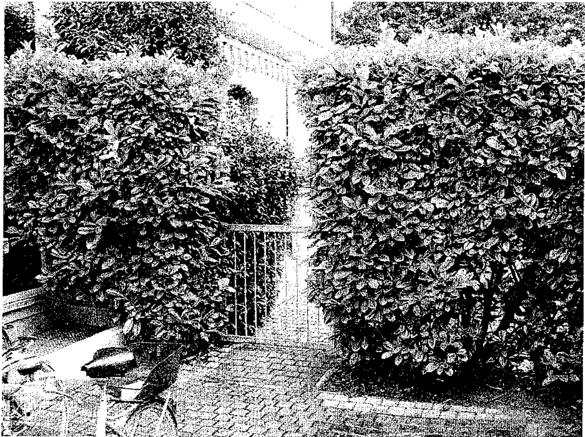
FOTO 2 – ingresso da vialetto condominiale
