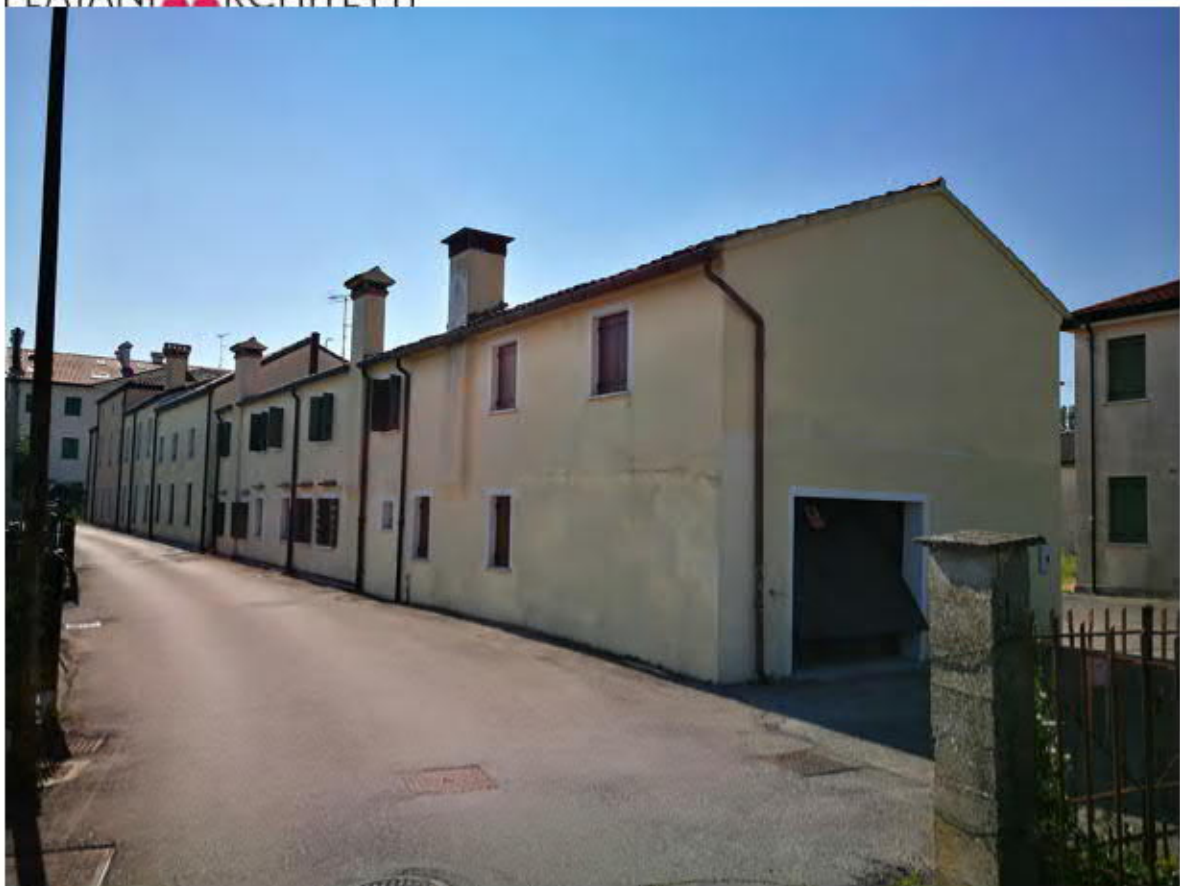
edificio a schiera, vincolo: grado di protezione 2
