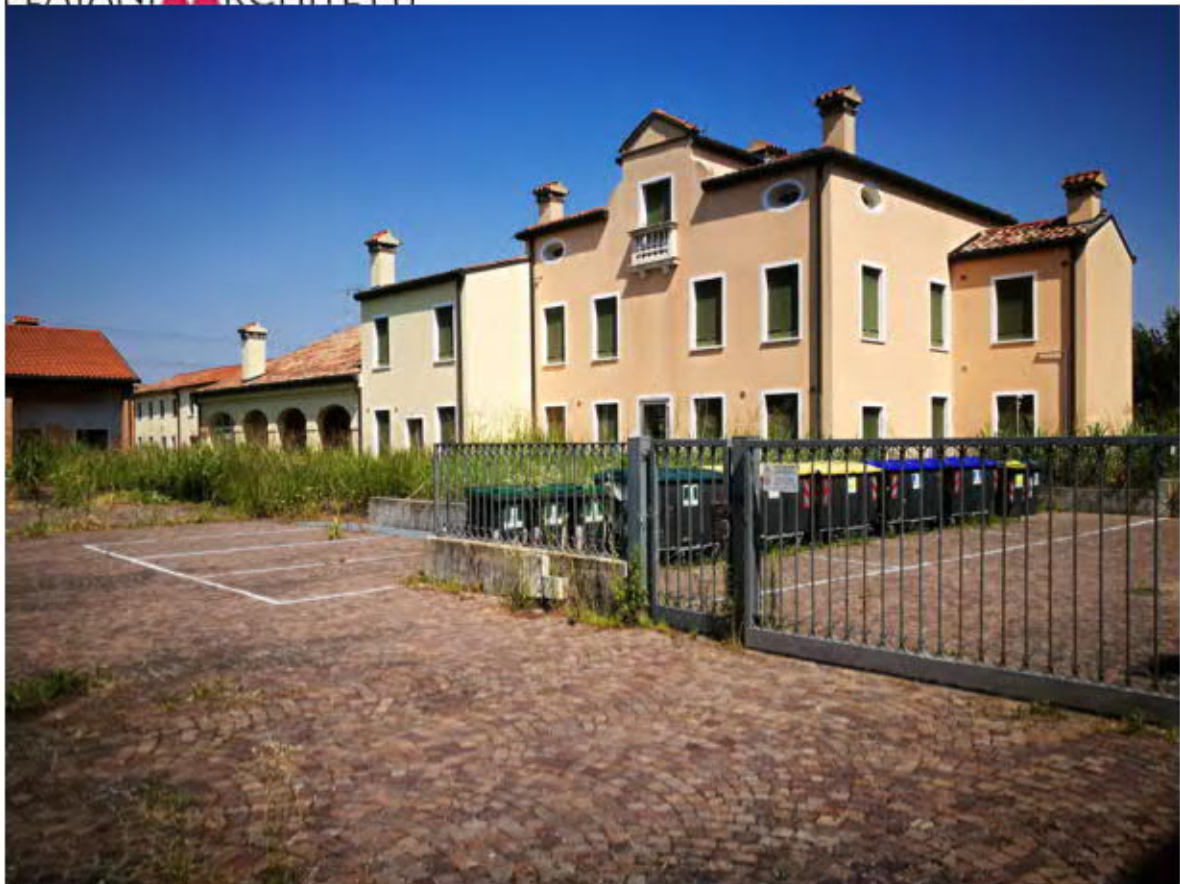
Villa d'epoca con portico e barchessa, vincolo: grado di protezione 2
