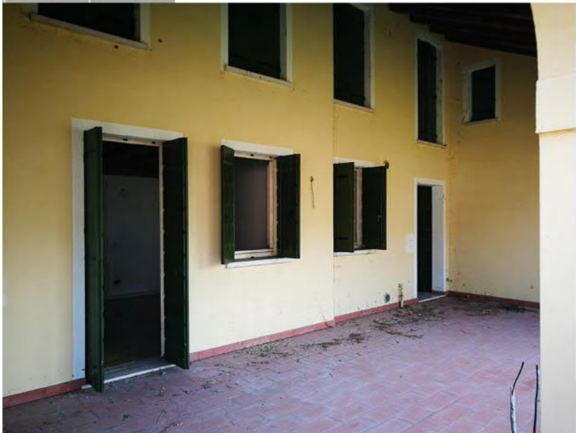
Ingresso dal portico
