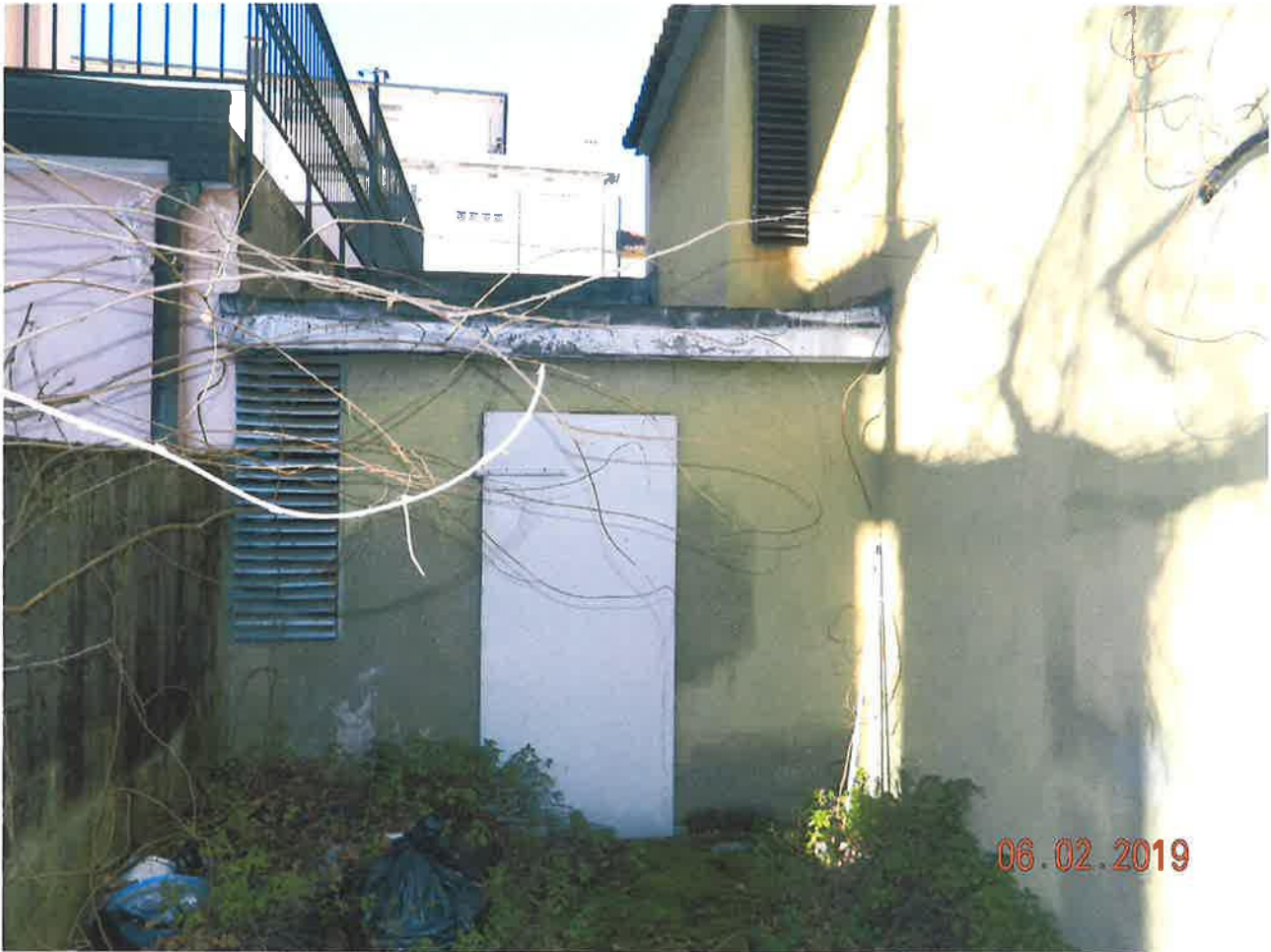
Fabbricato da cielo a terra – Vista esterna: locale impianti U.T.A.
