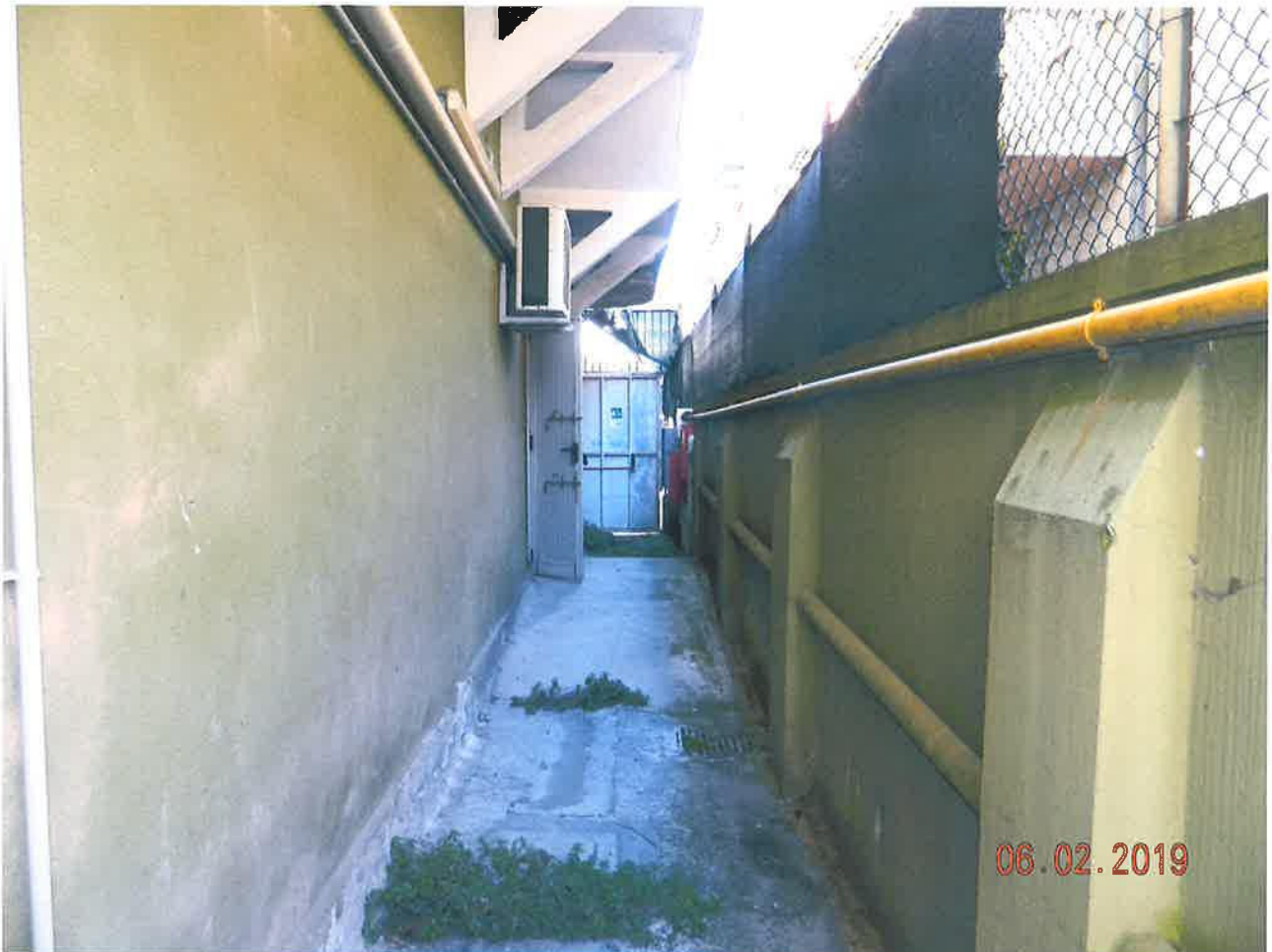
Fabbricato da cielo a terra – Vista del percorso esterno
