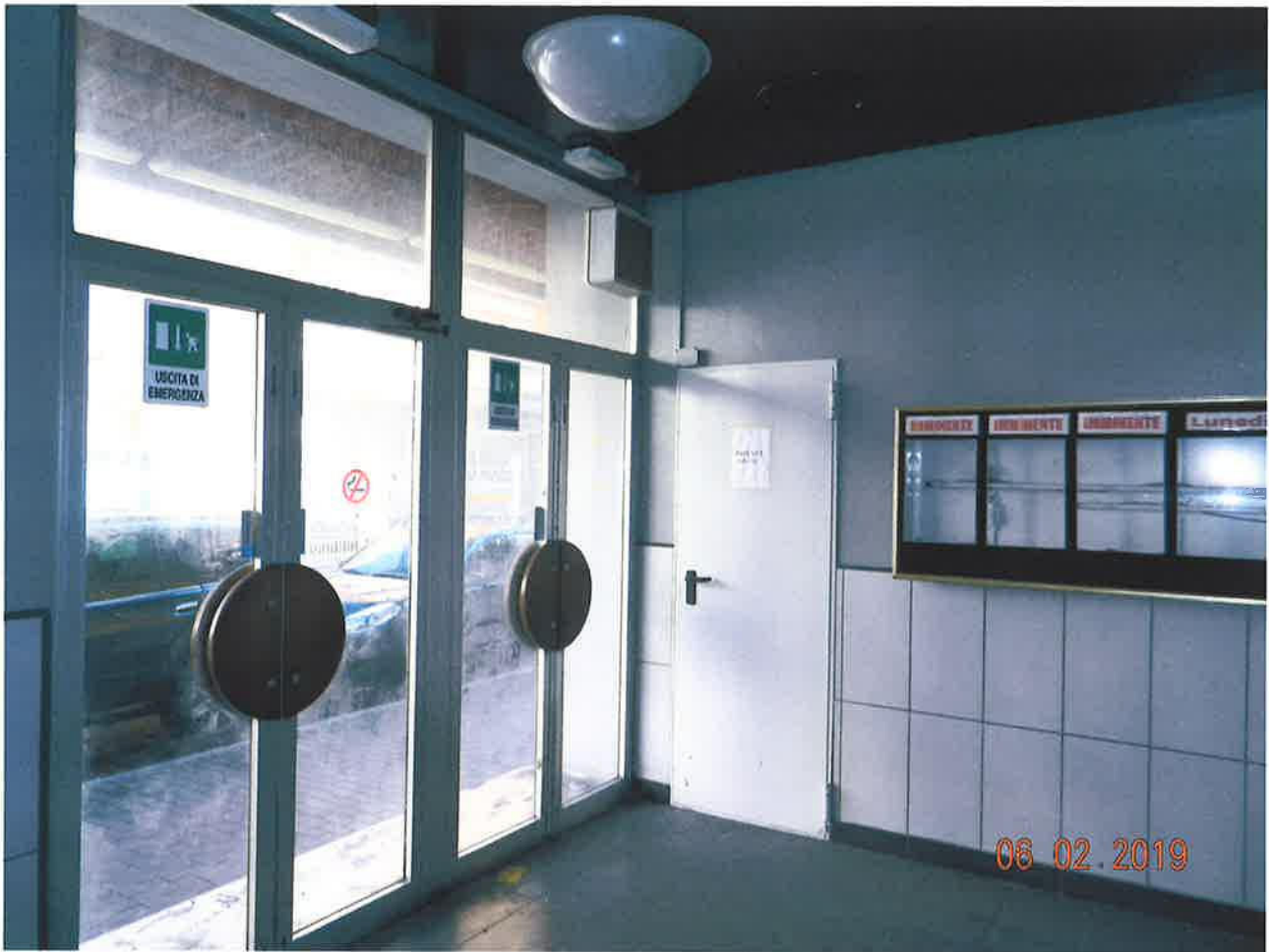
Fabbricato da cielo a terra – Vista interna: atrio verso ingresso
