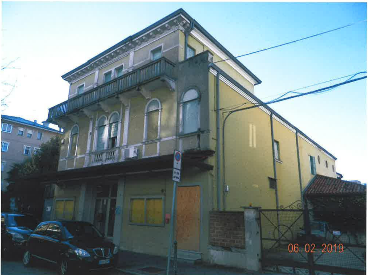
Fabbricato da cielo a terra – Vista esterna da Via Premuda
