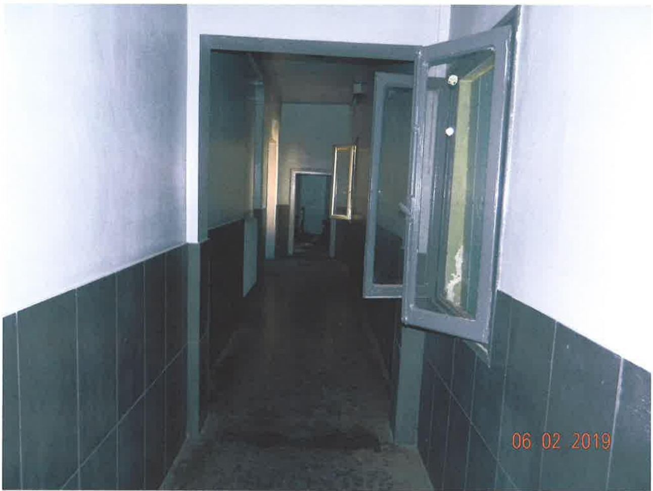
Fabbricato da cielo a terra – Vista interna: corridoio piano primo
