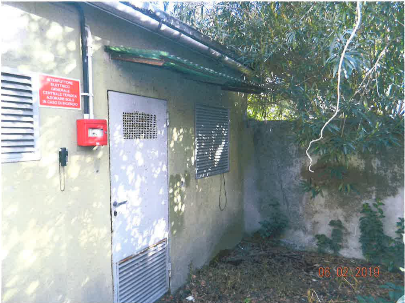
Fabbricato da cielo a terra – Vista esterna: locale impianti C.T.
