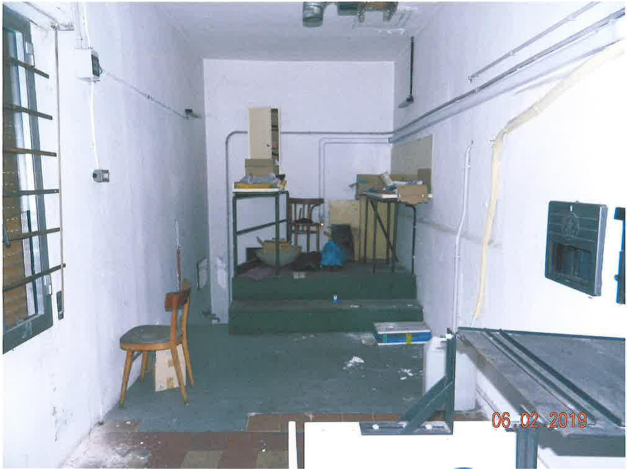
Fabbricato da cielo a terra – Vista interna: cabina di proiezione
