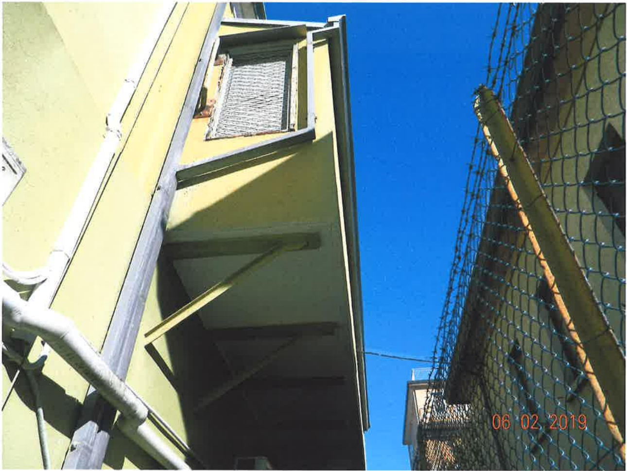
Fabbricato da cielo a terra – Vista del corridoio a sbalzo
