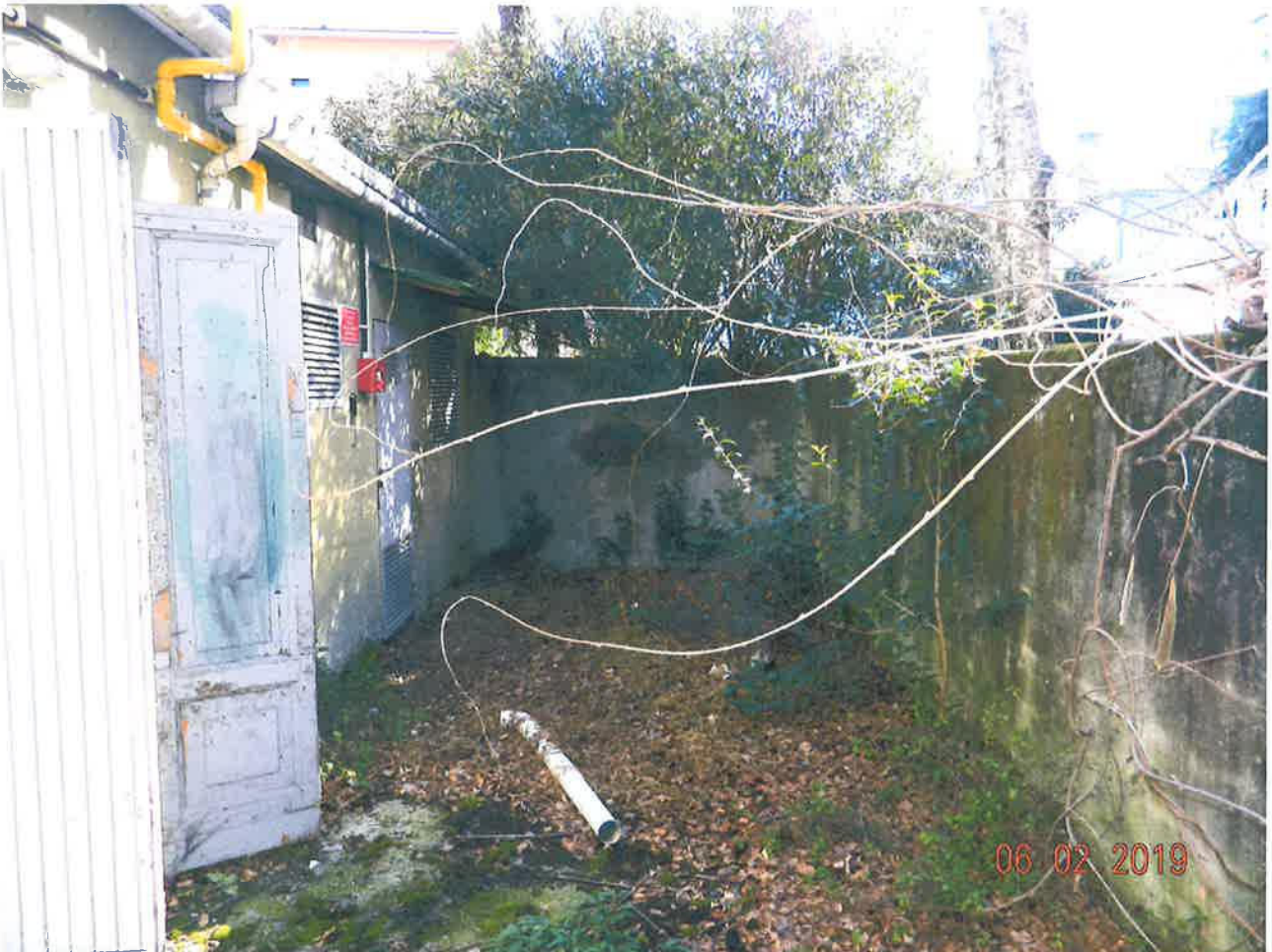
Fabbricato da cielo a terra – Vista del piccolo cortile interno
