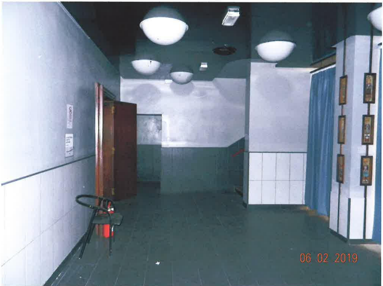
Fabbricato da cielo a terra – Vista interna: atrio verso platea
