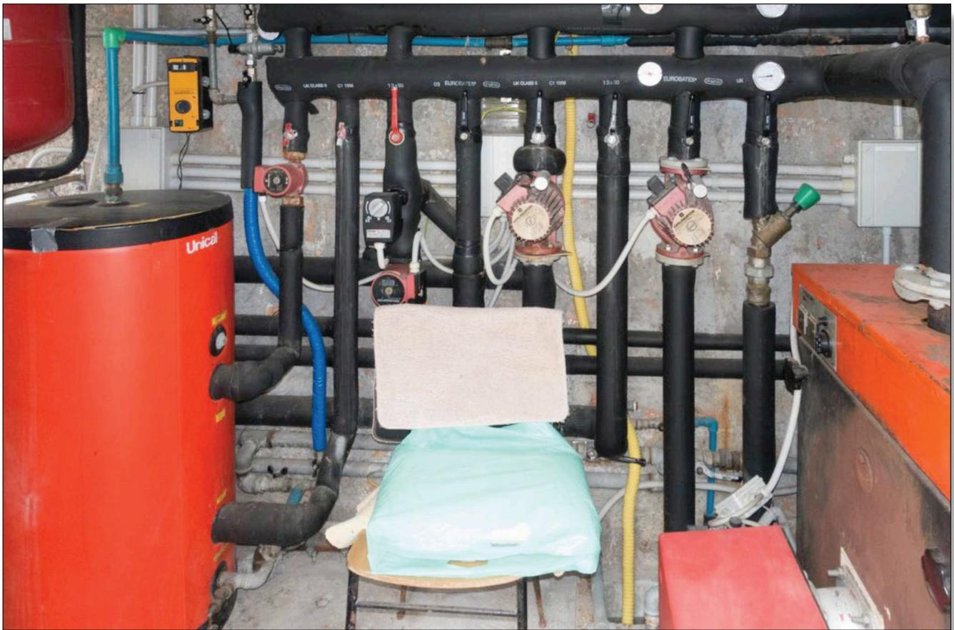
Foto n. 11) Vista delle caldaie e delle pompe
