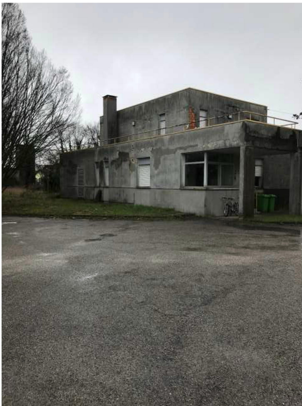
Veduta facciata sub. 7 – 8 – 9 – 29
