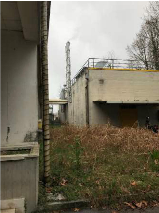
Veduta sub. 6 locale tecnico.
