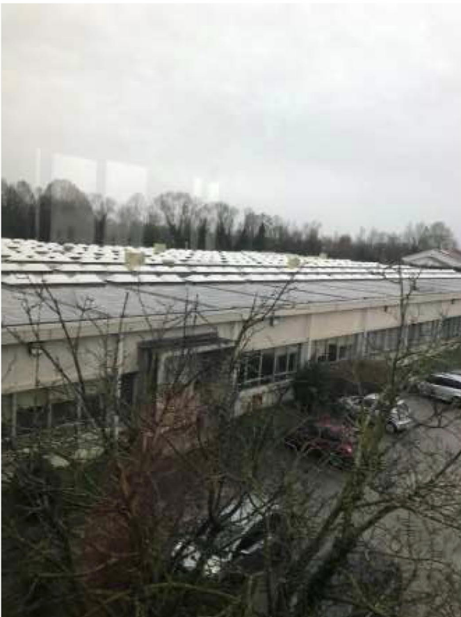
Veduta copertura sub. 26 e 27
