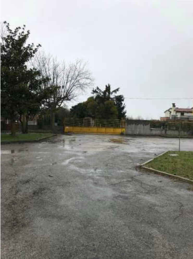
Veduta piazzale sub. 20 ingresso carrabile
