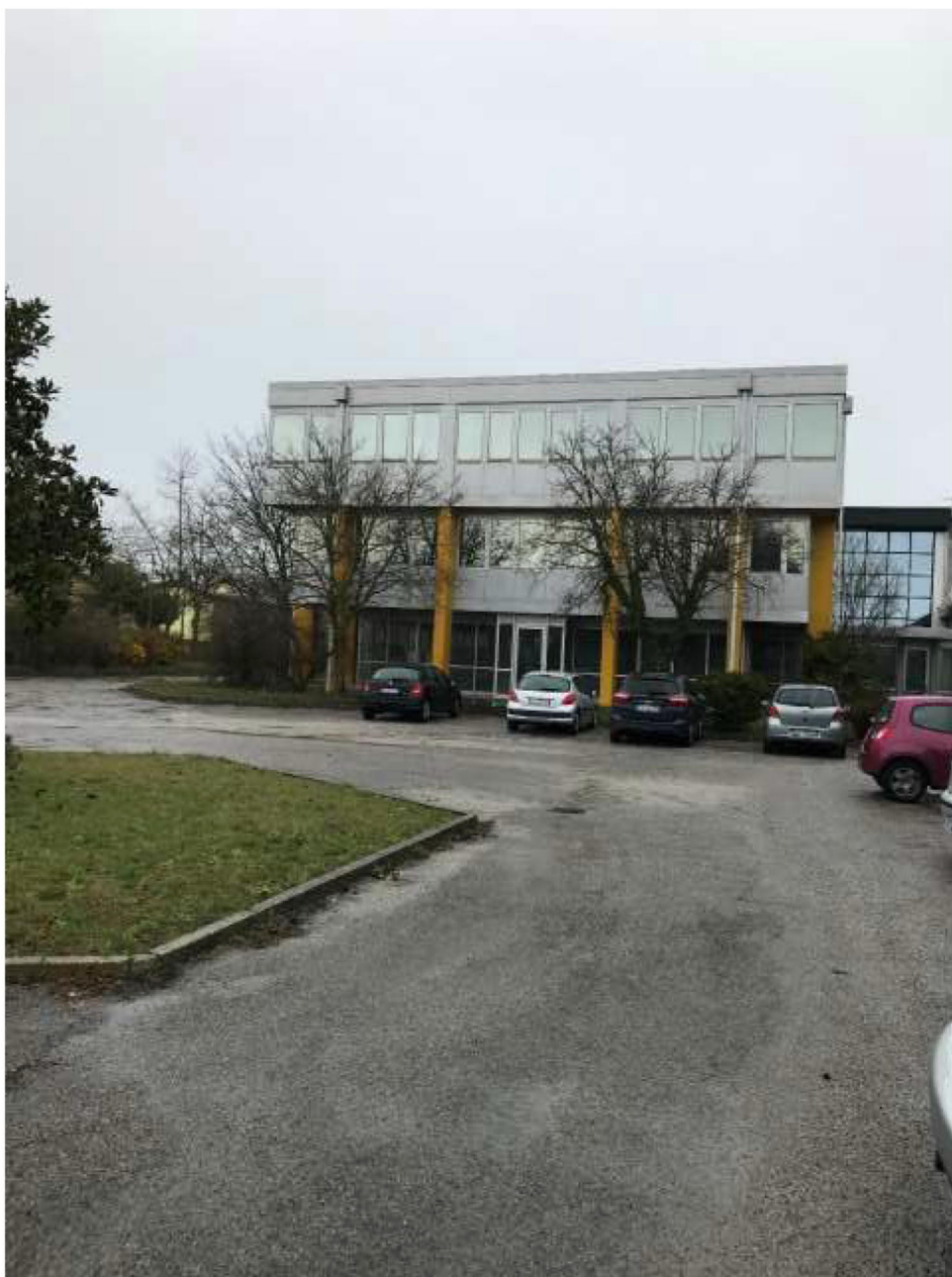
Veduta prospetto sub. 5
