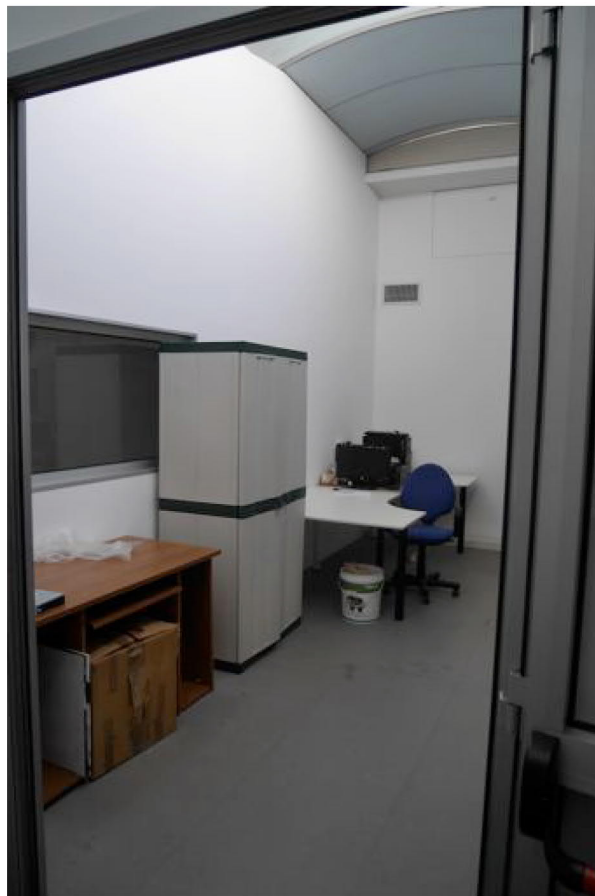
FOTO 11 - Piano primo. La sala registrazione realizzata senza la necessaria.
