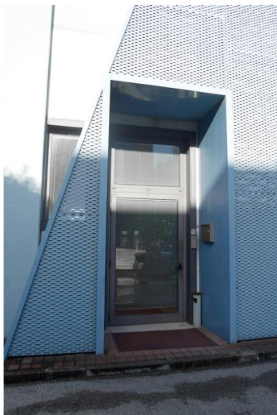
FOTO 5 - L'ingresso di servizio.
