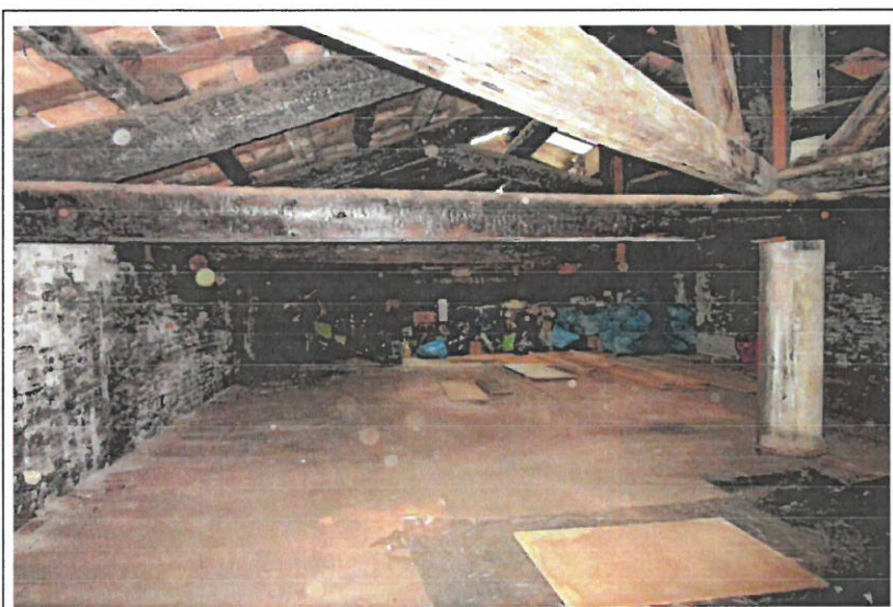
Fotogramma 07/09 – Particolare del locale sottotetto.
