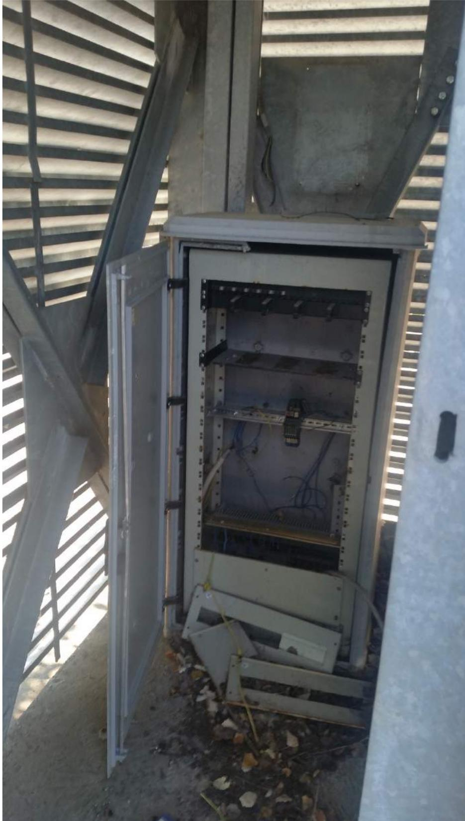
Foto n. 35 – vista del quadro elettrico della torre illuminazione con evidente manomissione ed asportazione degli accessori e dei cavi elettrici
