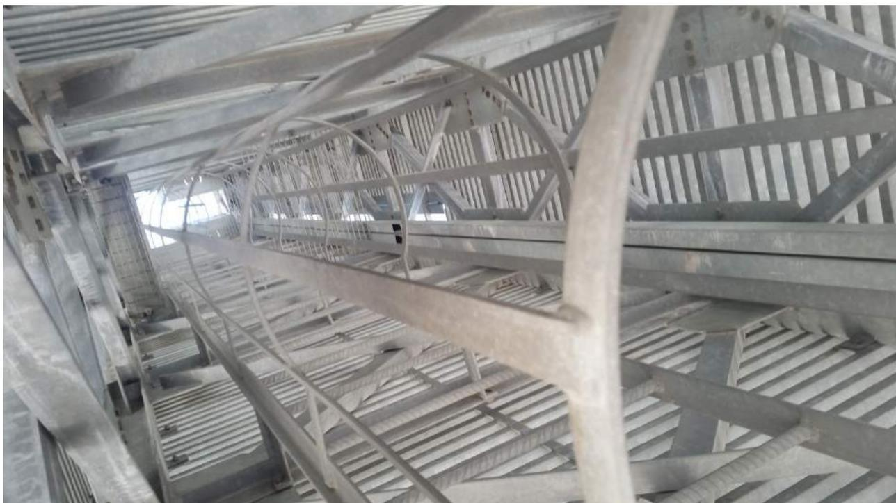
Foto n. 12 – vista interna della struttura metallica delle torri di illuminazione pubblica
