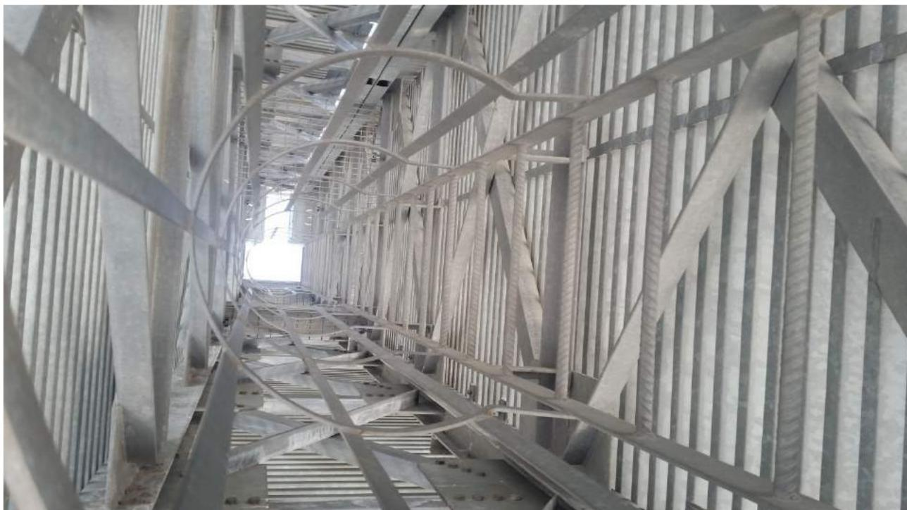
Foto n. 13 – vista interna della struttura metallica delle torri di illuminazione pubblica
