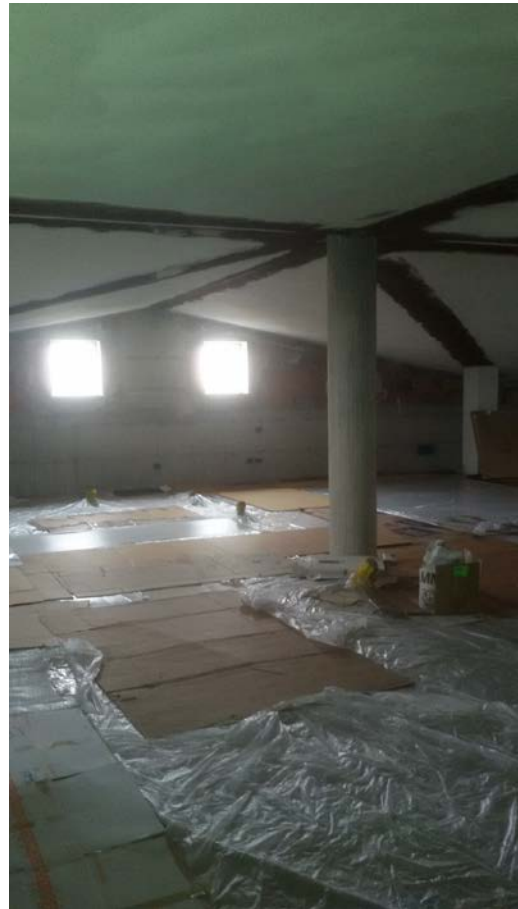
Foto n. 4 - vano unico interno
