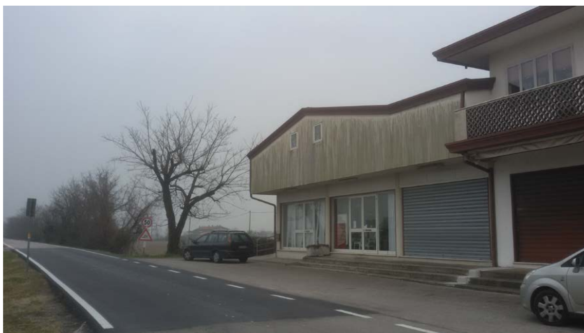
Foto n. 1 – vista fronte nord (abitazione al P.1°)
