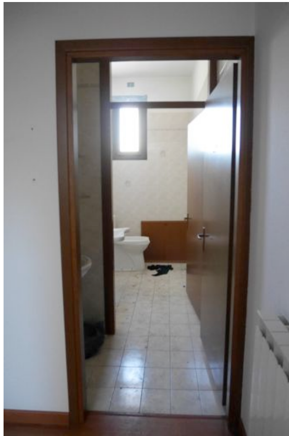
FOTO 11 - Il corpo ad uso uffici. Piano terra. I bagni.
