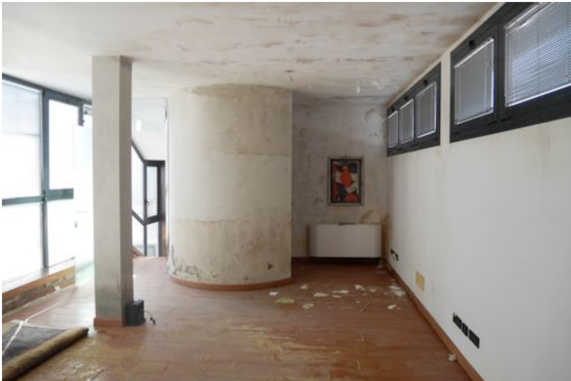
FOTO 10 - Il corpo ad uso uffici. Piano primo.
