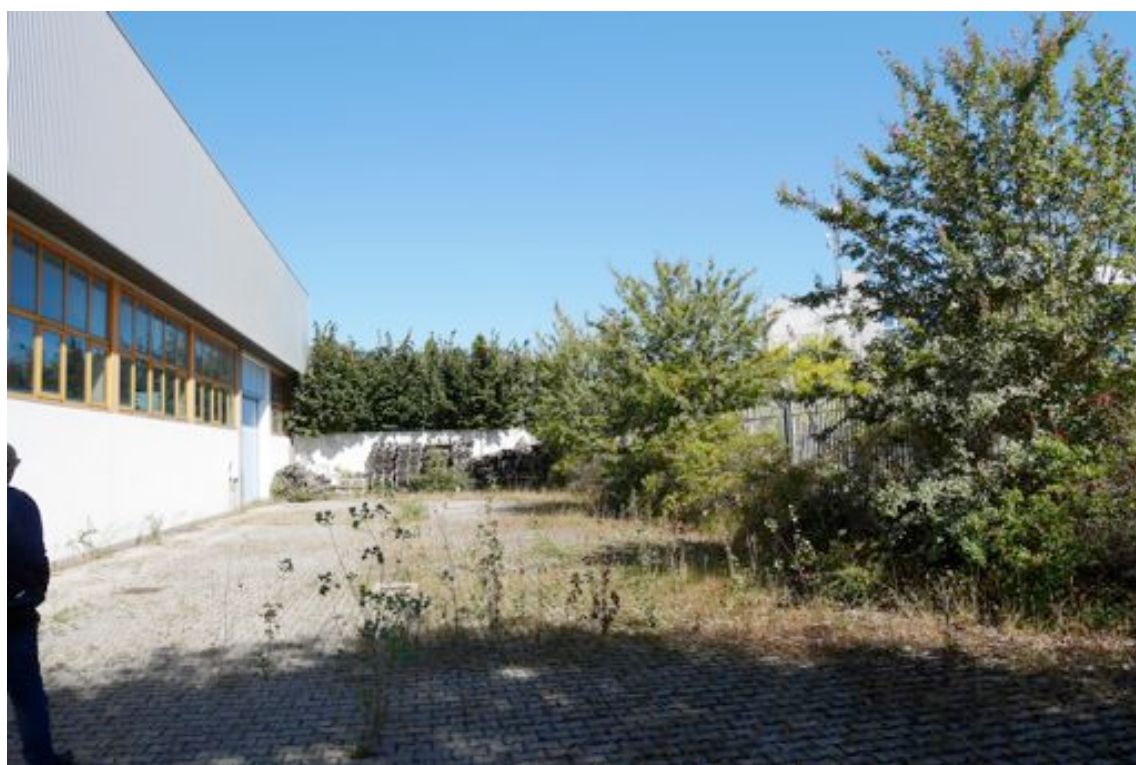
FOTO 4 - Il corpo ad uso laboratorio/officina e lo scoperto ad uso esclusivo.
