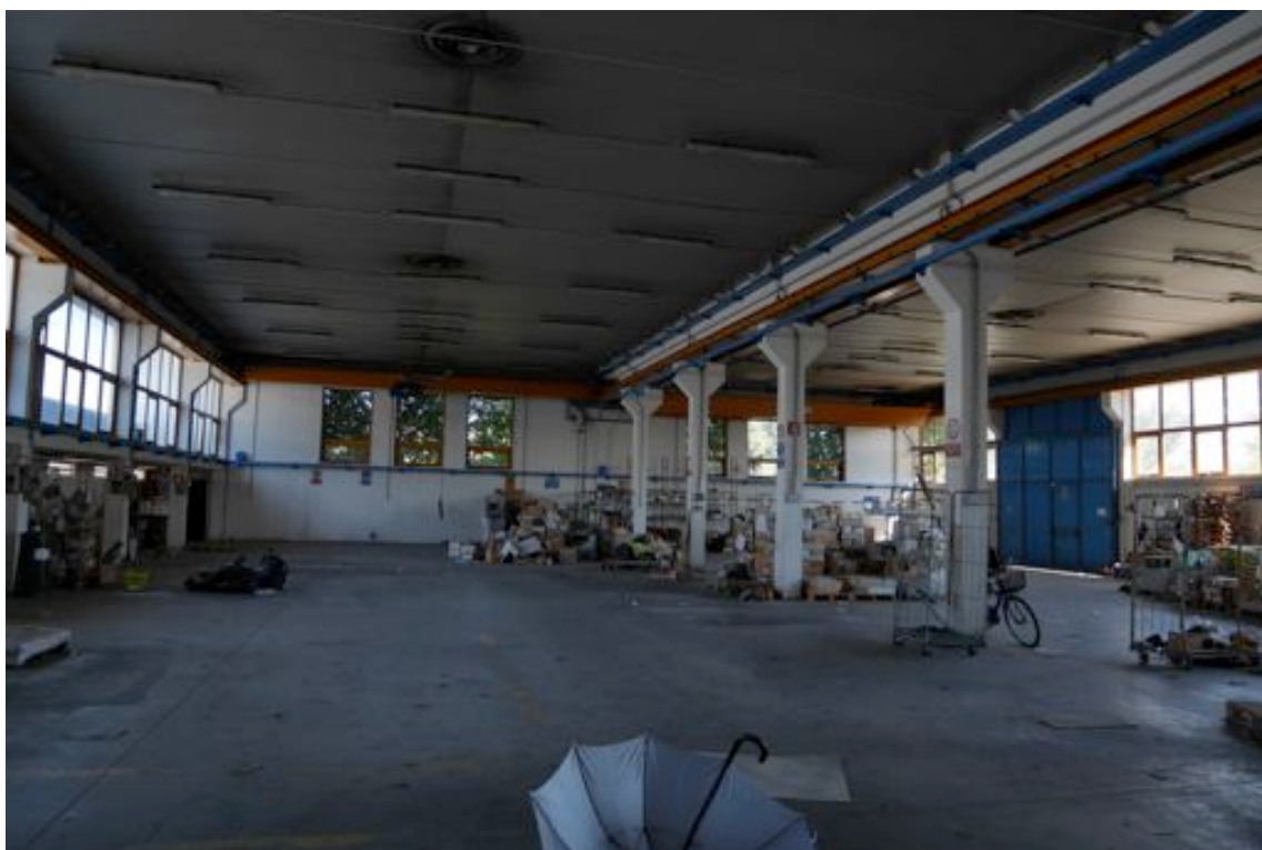
FOTO 13 - Il corpo ad uso laboratorio/ officina. Piano terra.
