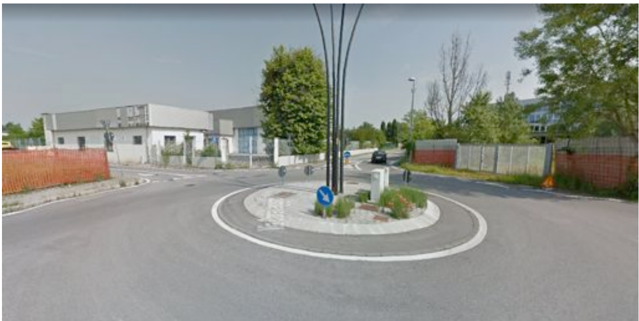
FOTO 2 - Il complesso immobiliare in esame dalla Via Caravaggio. L'accesso principale.
