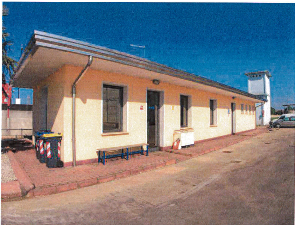
Blocco servizi: spogliatoi e mensa
