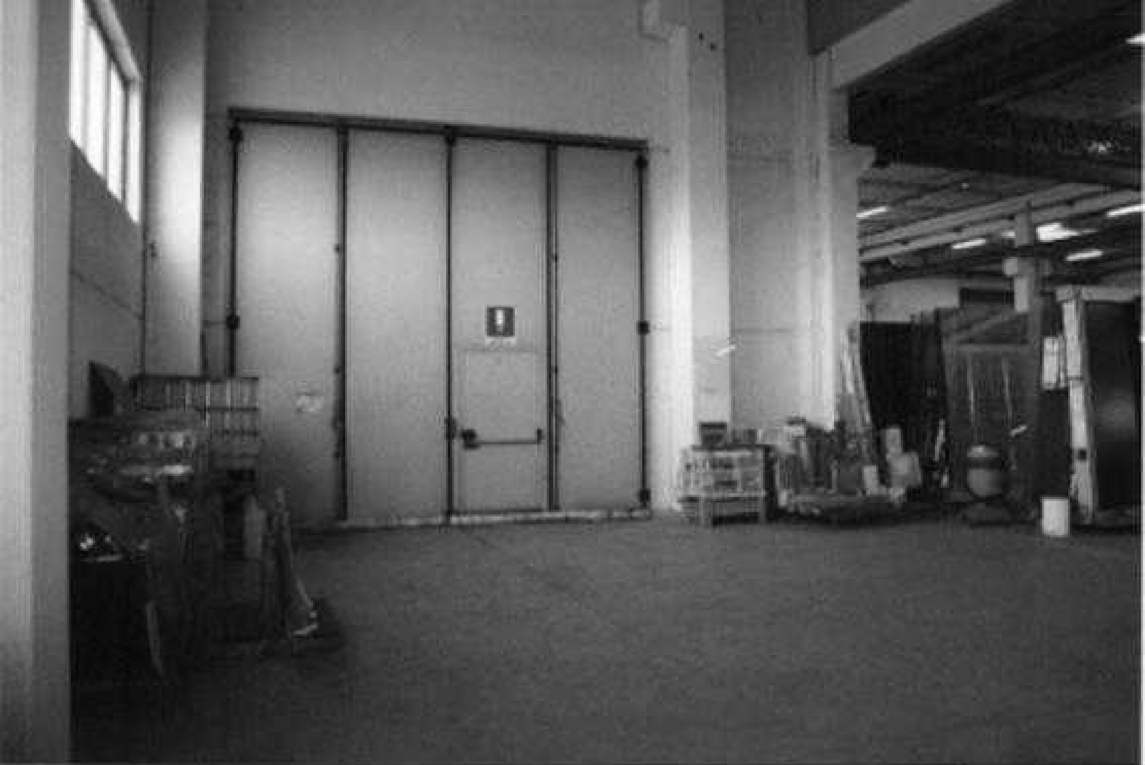
particolare fronte est con accesso mezzi
