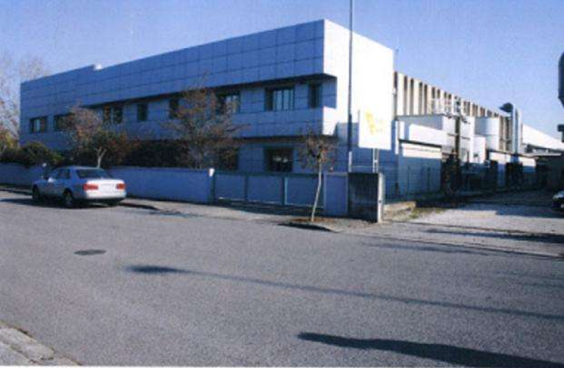
1 vista da Via Pacinotti - corpo A e B
