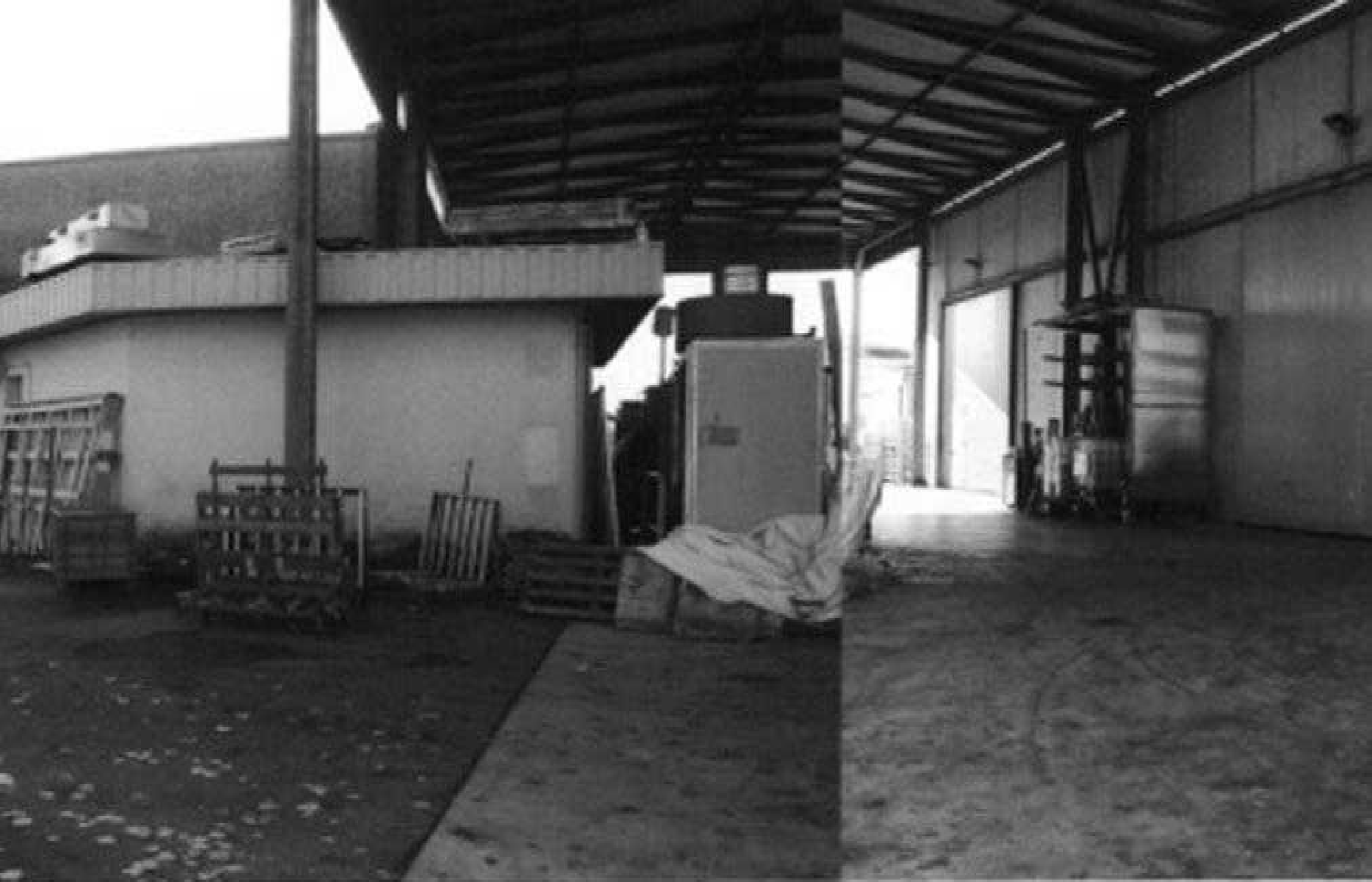
portico con tettoia tra i corpi B e E
