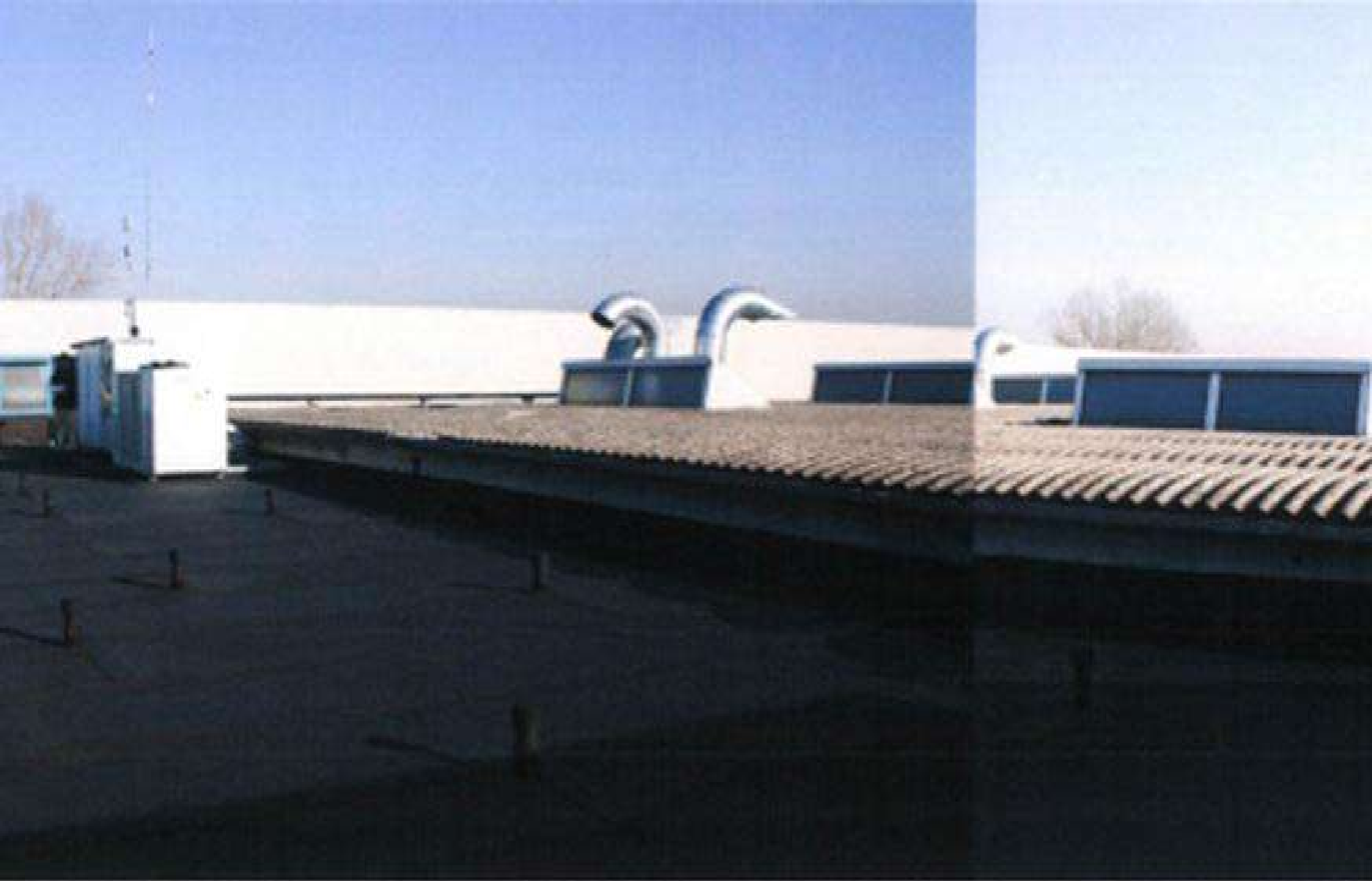
vista lastrico solare con impianti e copertura corpo
