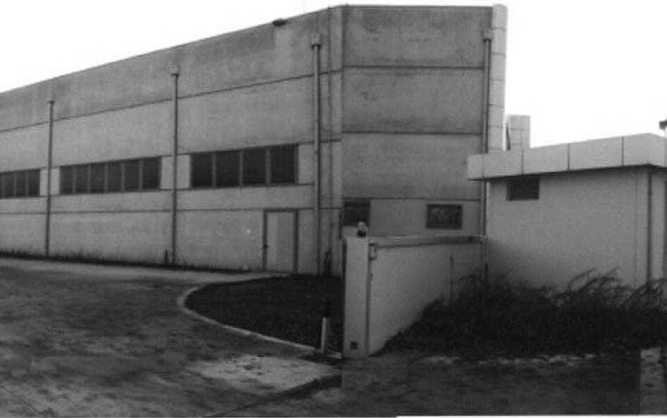
Arretrato da Via Pacinotti - centrale elettrica e corpi A
