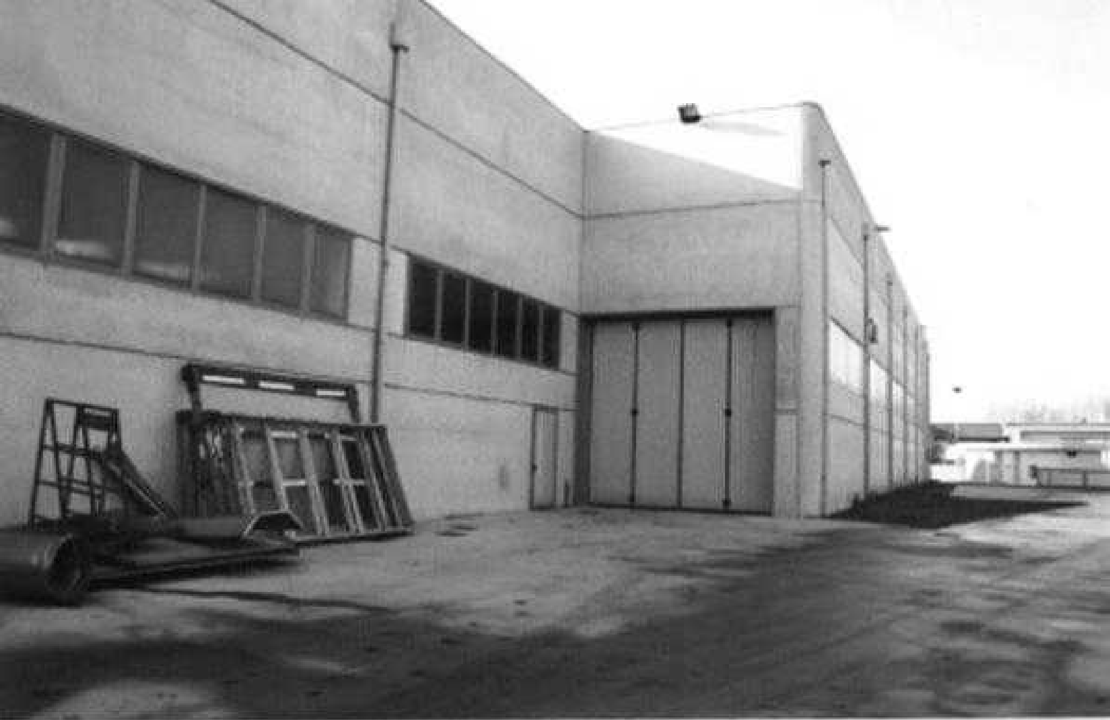
fronte nord corpo B (laboratorio)
