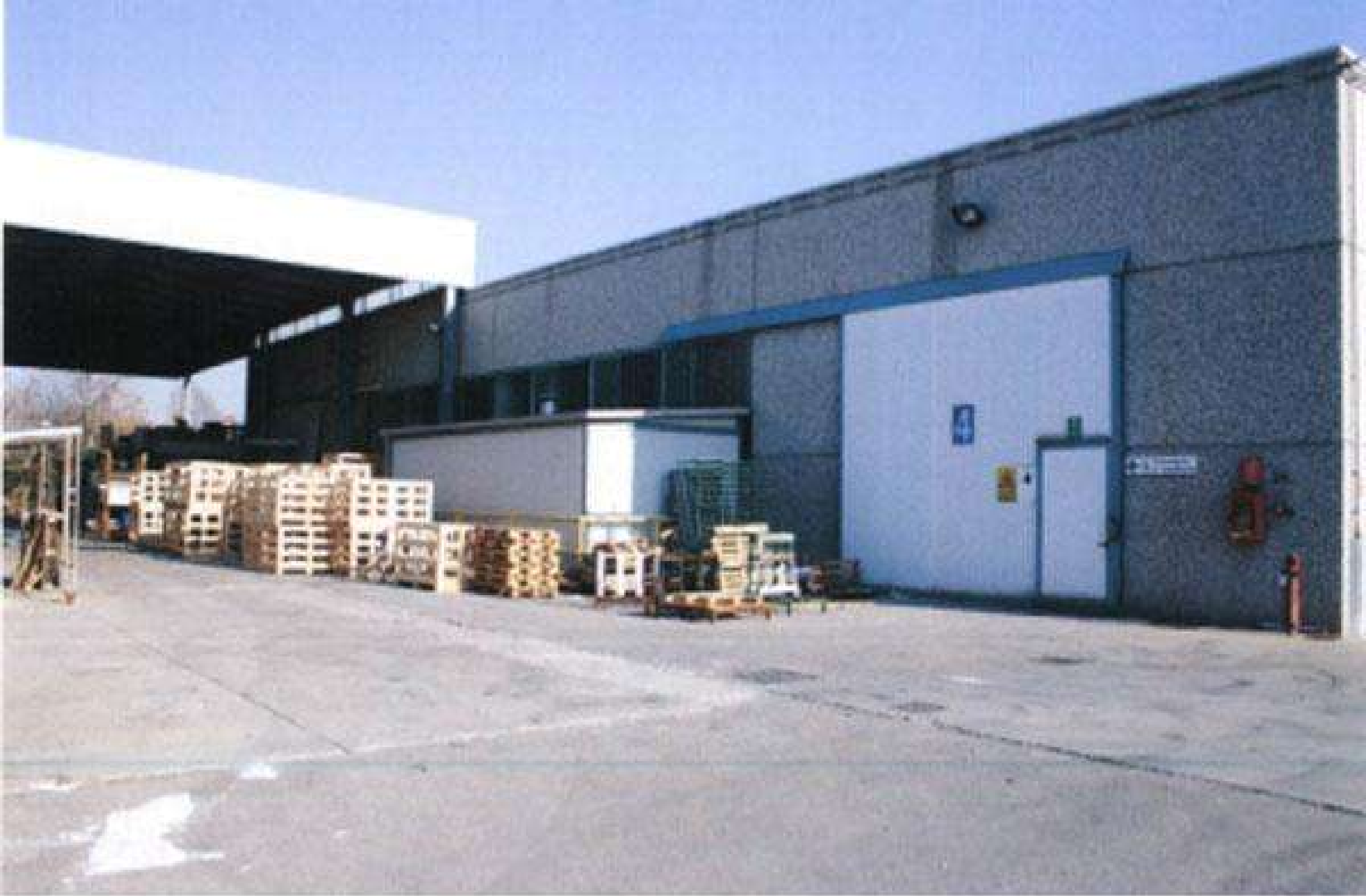
fronte ovest corpo E (laboratorio)
