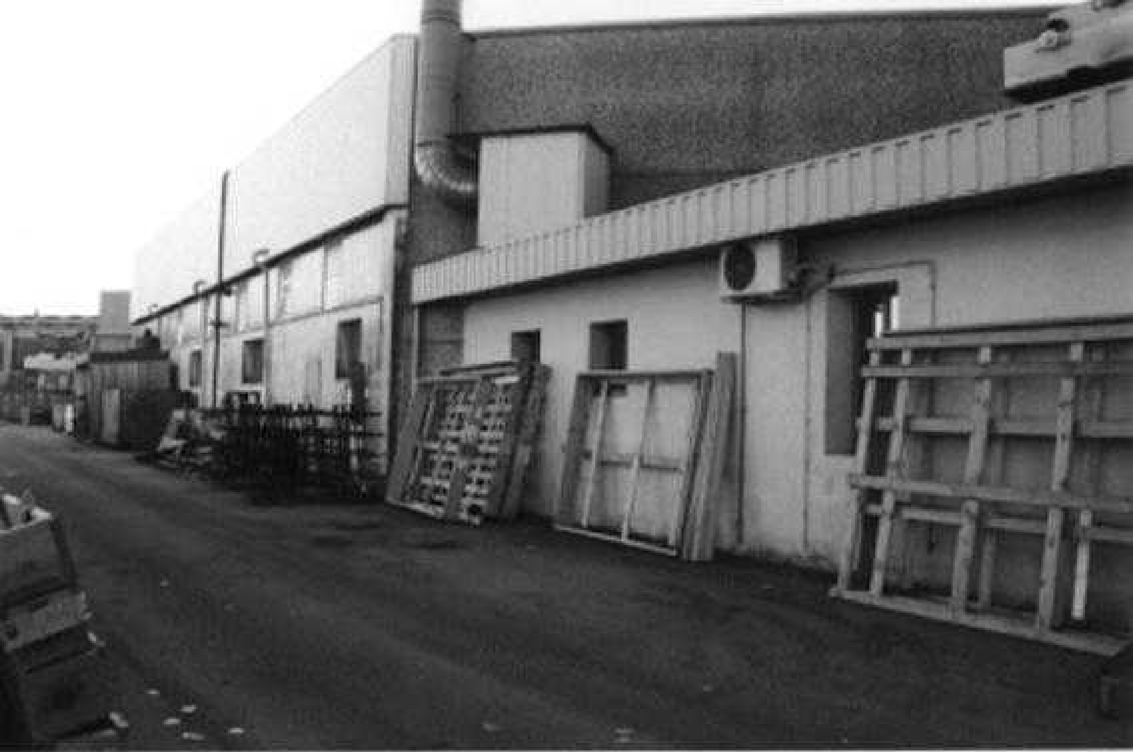
fronte est corpo E (laboratorio e uffici)
