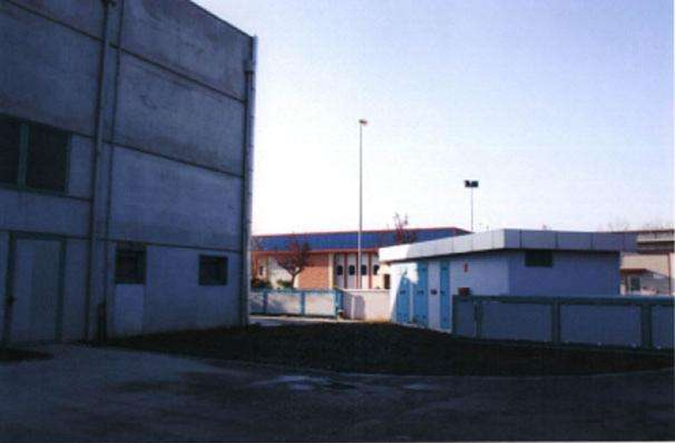
fronte nord corpi A e B + centrale elettrica
