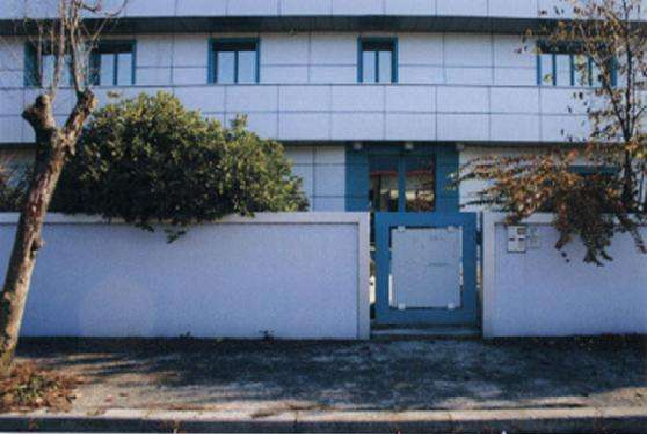
Ingresso corpo A ad uffici
