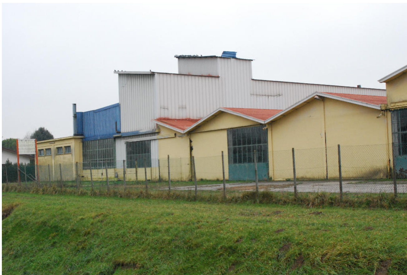
1 vista dal ponticello fronte nord
