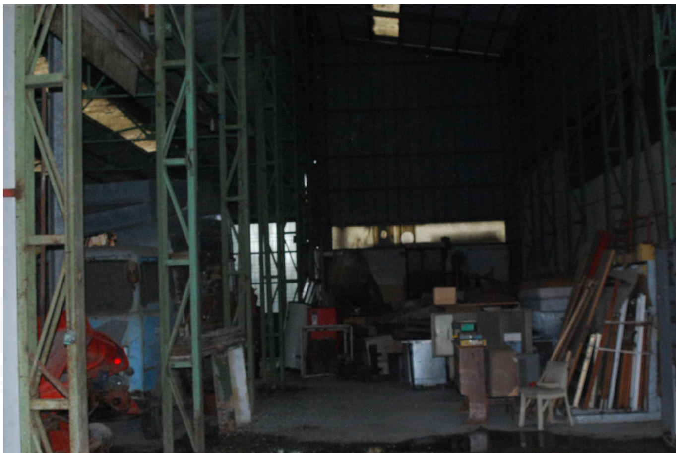
11 vista capannone ex prod. mangimi
