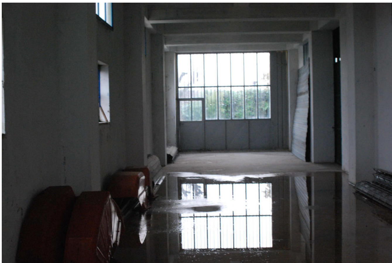
9 vista capannone ala est ex produzione mangimi
