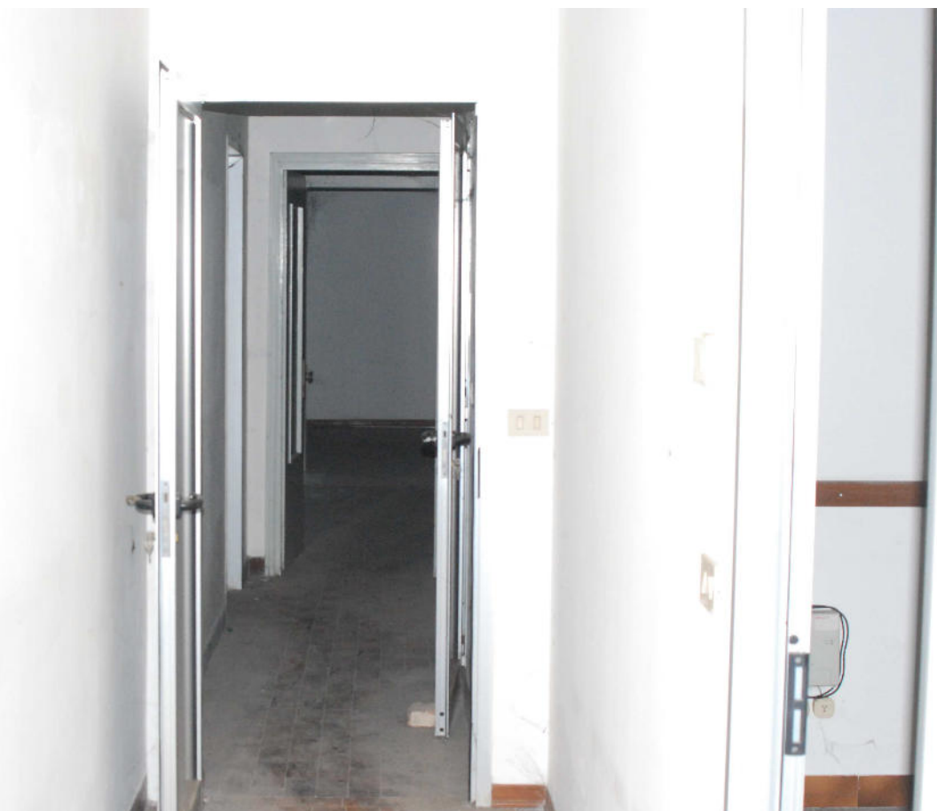
15 vista zona bagni spogliatoi
