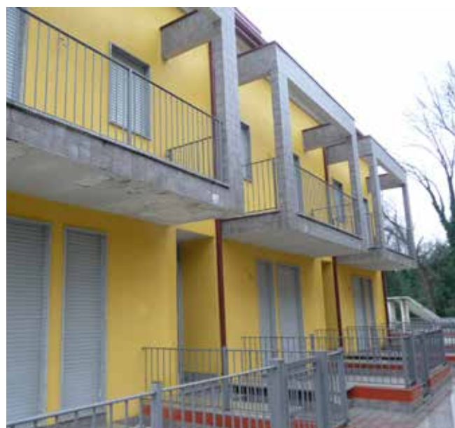
Vista complesso corpo A, lato Est
