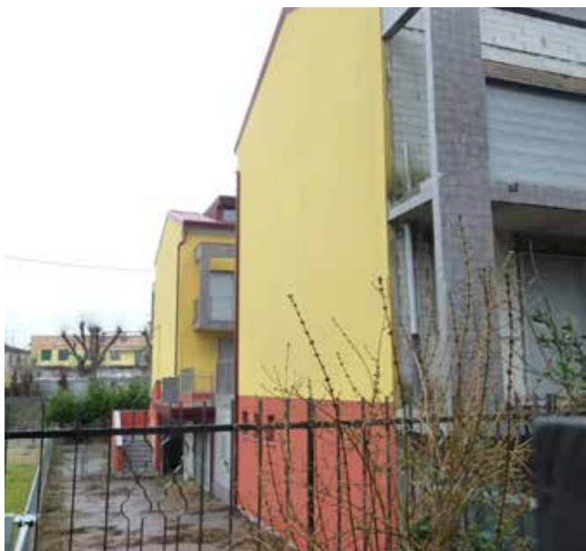
Vista esterna lato Nord
