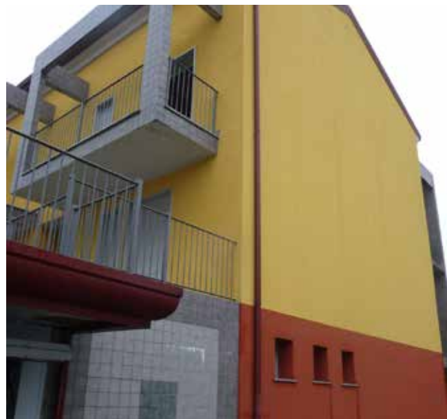
Vista esterna lato Nord, complesso corpo B
