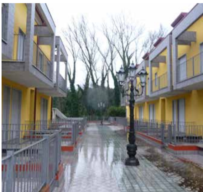
Vista piano terra, piazza sopra i garages
