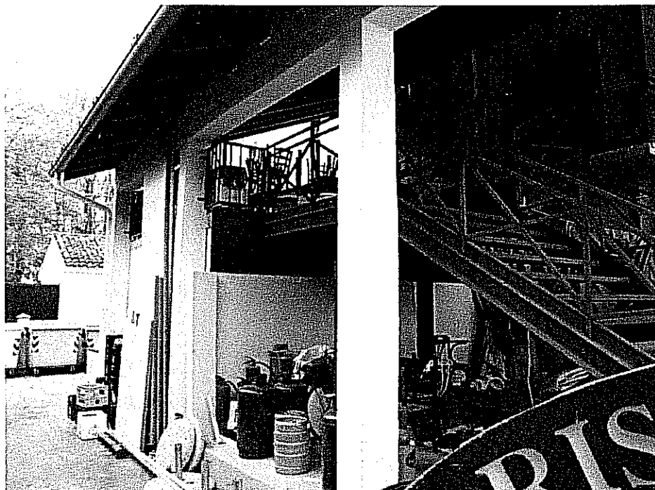
Portico con magazzino da demolire
