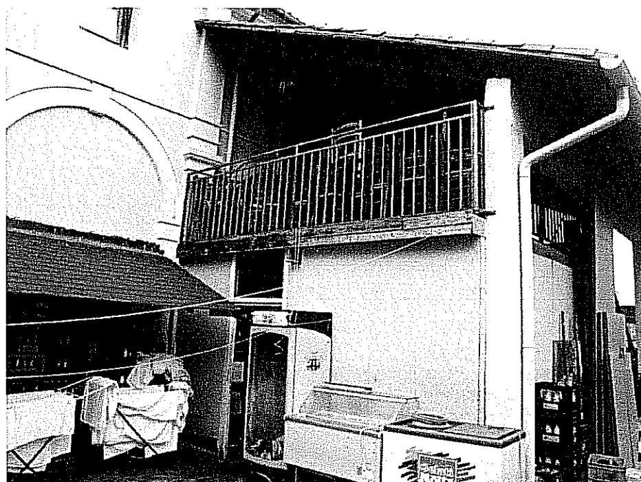
Portico con magazzino da demolire
