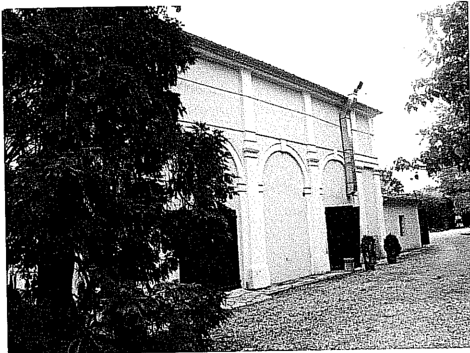
Facciata lato Nord prospiciente altra proprietà
