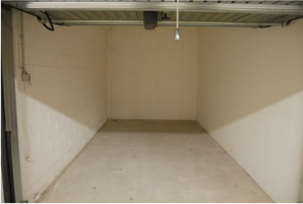
FOTO 14 - Piano interrato. L'interno di uno dei quattro garage.
