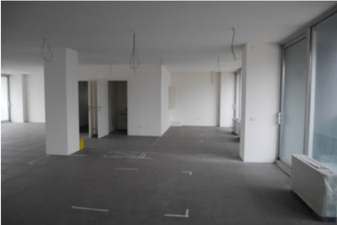
FOTO 8 - Piano secondo. L'unità in esame di cui al sub. 57. L'ampio locale privo di divisori. Si notano gli accessi agli antibagno.
