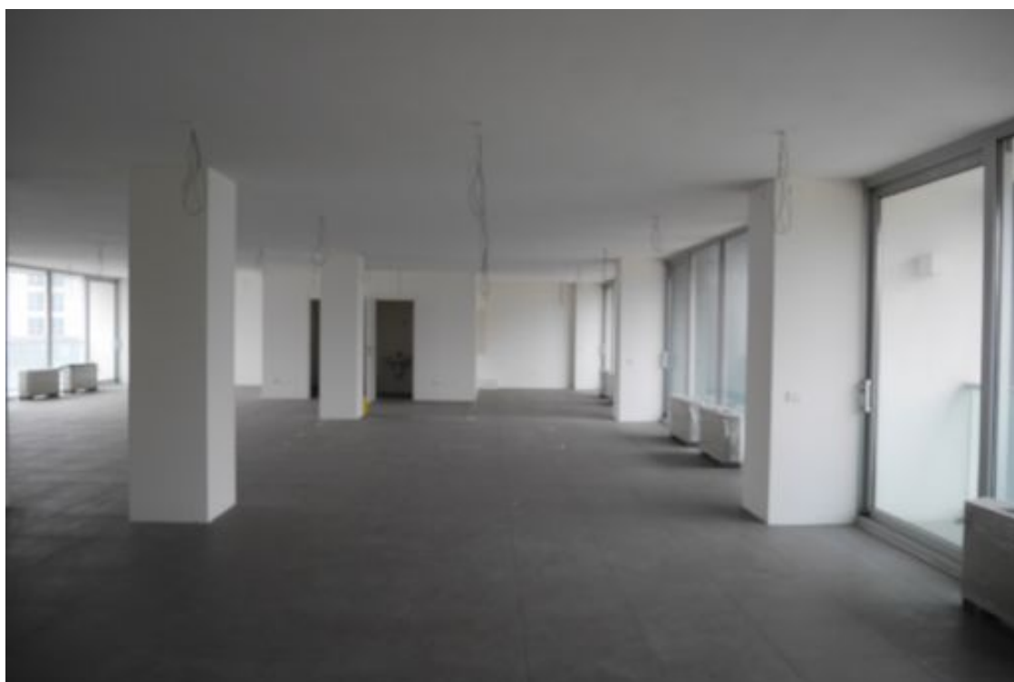
FOTO 7 - Piano secondo. L'unità in esame di cui al sub. 57. L'ampio locale privo di divisori.
