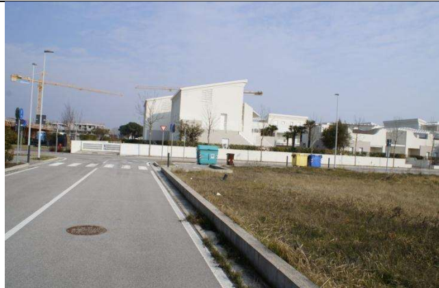
FOTO N°8 – altra vista con fronte via Verona
