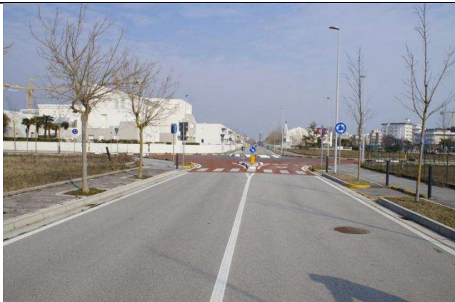
FOTO N°19 –vista del lotto a sx
