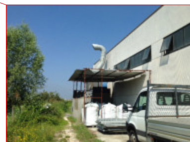
(3) Tettoia in lamiera abusiva
