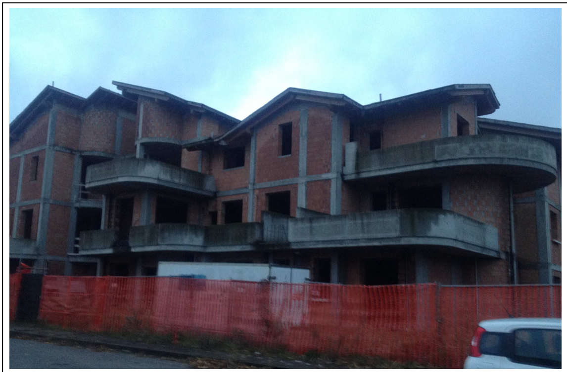
Foto n. 2: vista fronte nord – ovest da via Madonna della Salute
