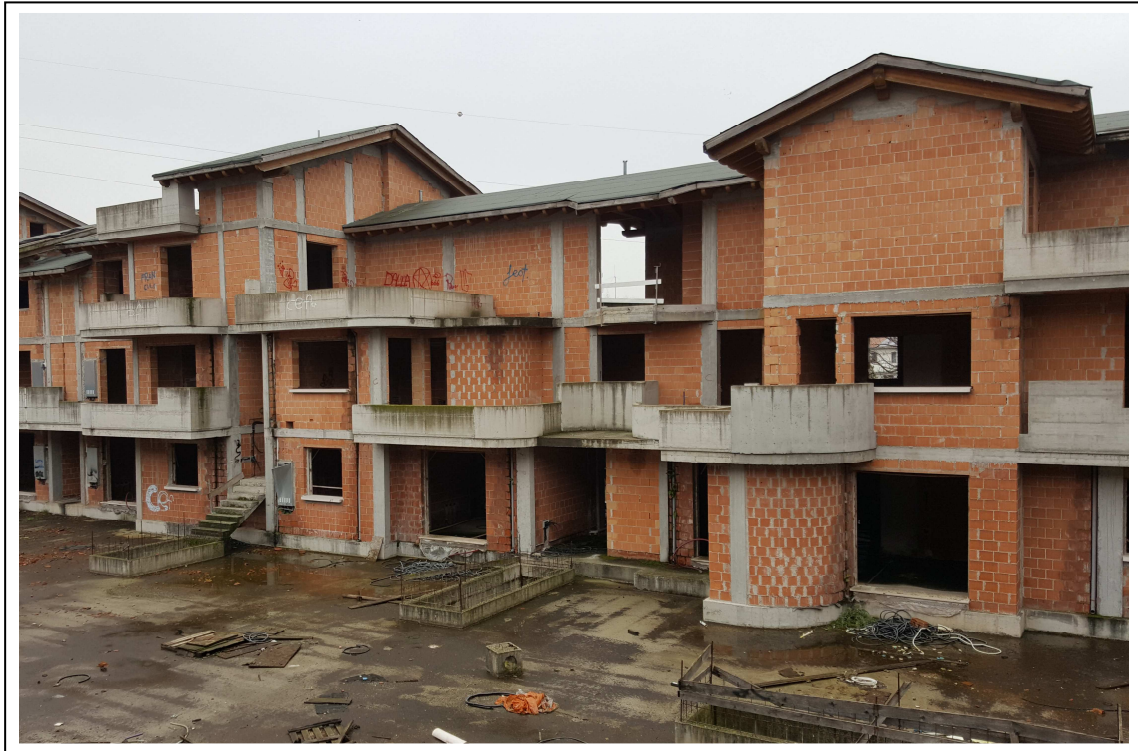
Foto n. 5: vista interna verso ovest
