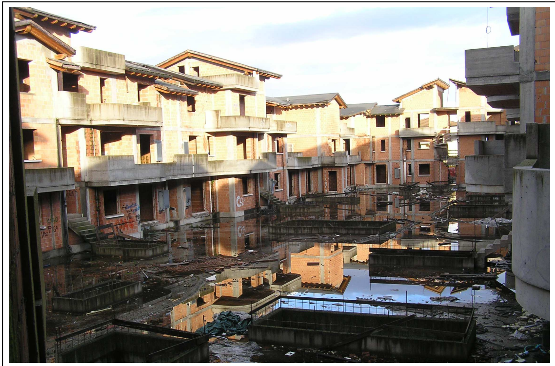
Foto n. 6: vista interna da nord verso sud - ovest
