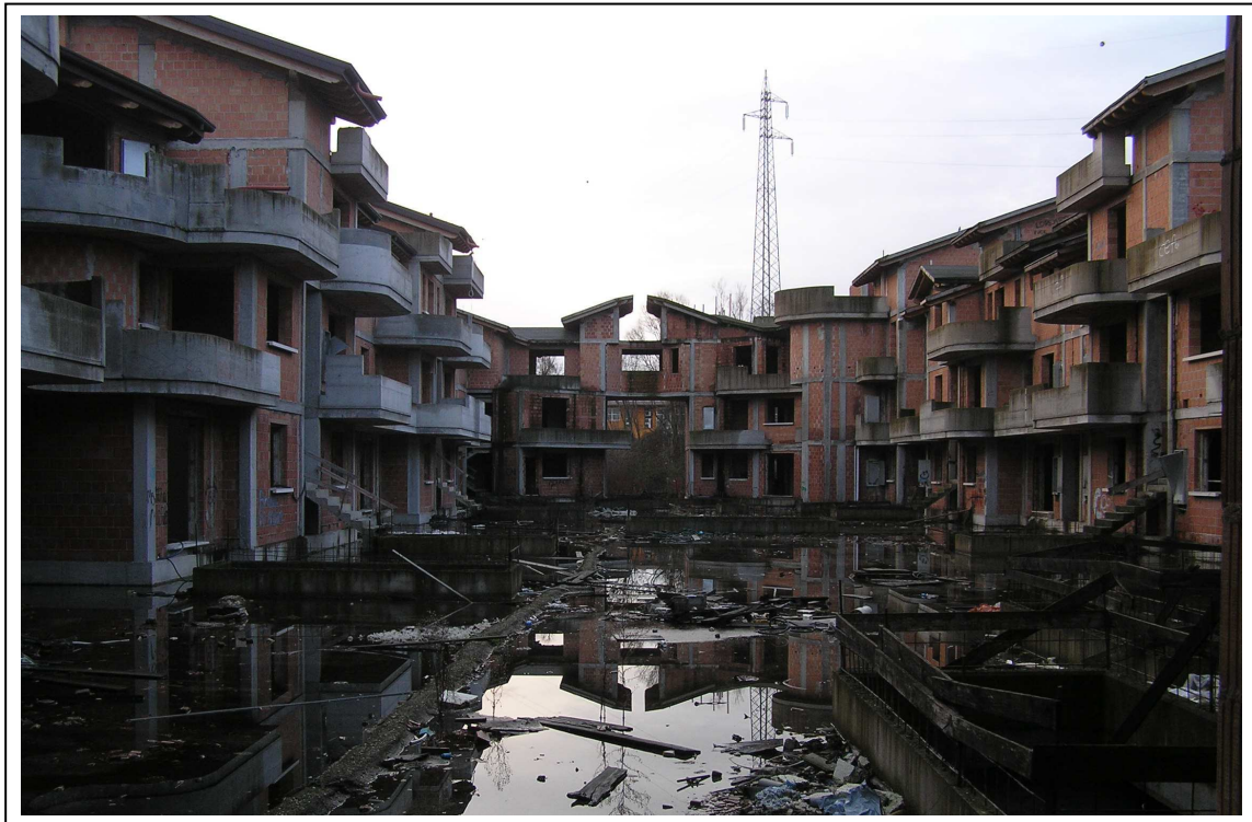
Foto n. 4: vista interna da nord verso sud
