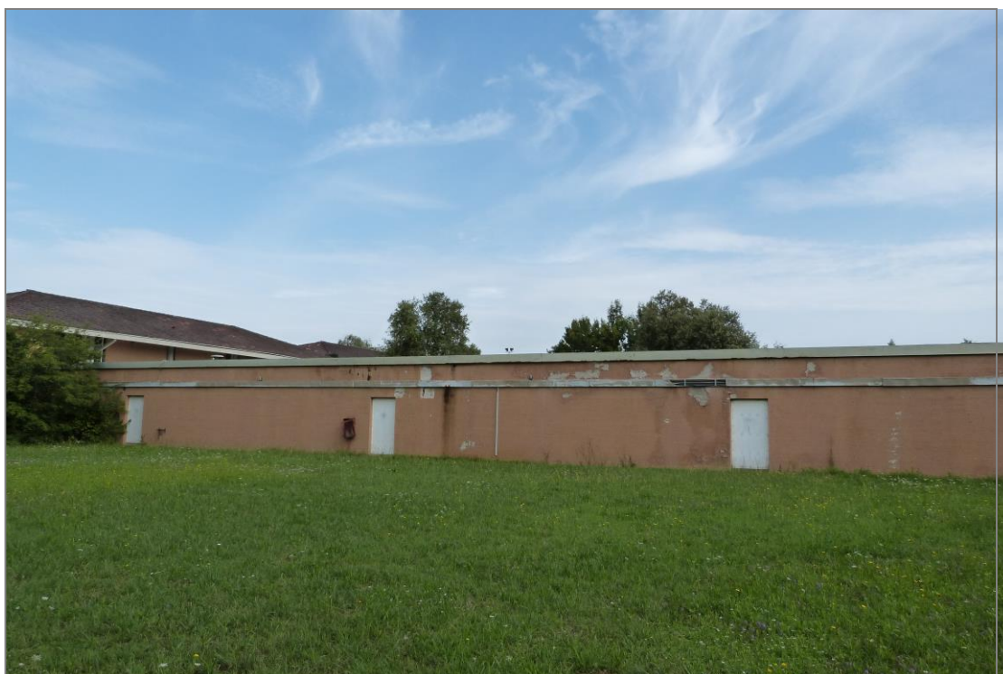
15 Vista di parte del prospetto Sud del corpo centrale, di parte del prospetto Est del piano primo del corpo fronte strada e di parte dell'area scoperta.
