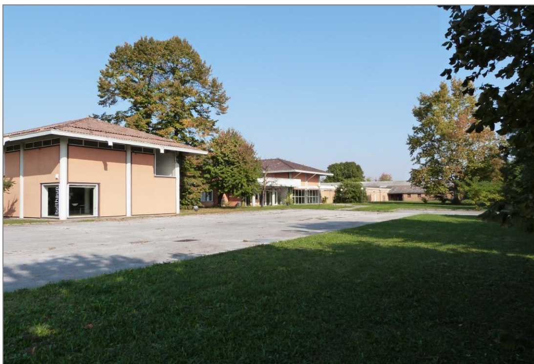
16 Vista di parte dei prospetti Sud e Ovest del corpo fronte strada e di parte dell'area scoperta. In fondo si intravedono il corpo centrale e l'abitazione del custode.
