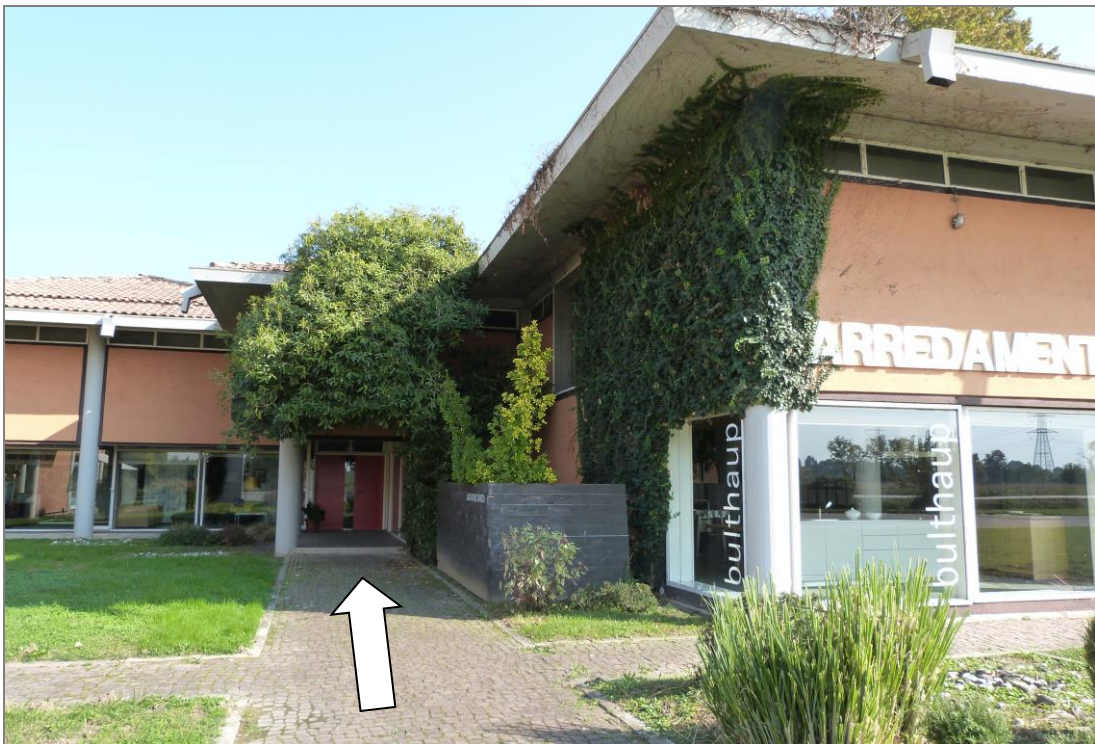
2 Particolare dell'ingresso al corpo fronte strada, indicato dalla freccia.
