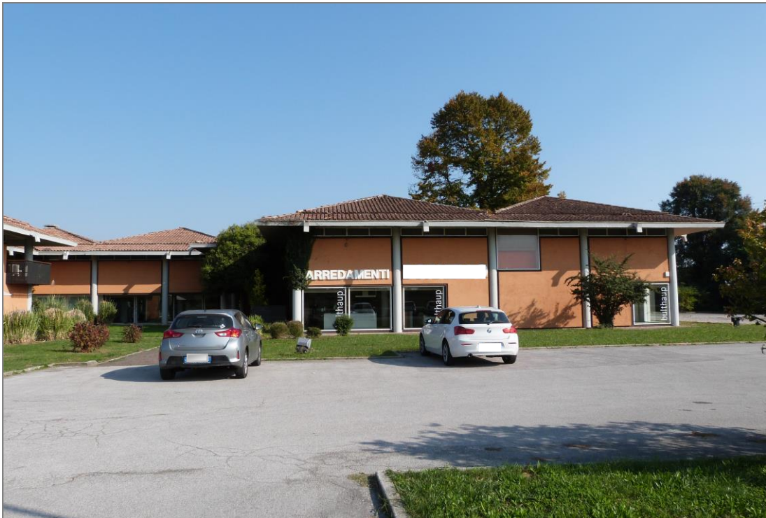
1 Vista, dall'accesso di via Terraglio, del prospetto Ovest del corpo fronte strada (ad uso esposizione e vendita mobili con uffici) e di parte dell'area scoperta.
