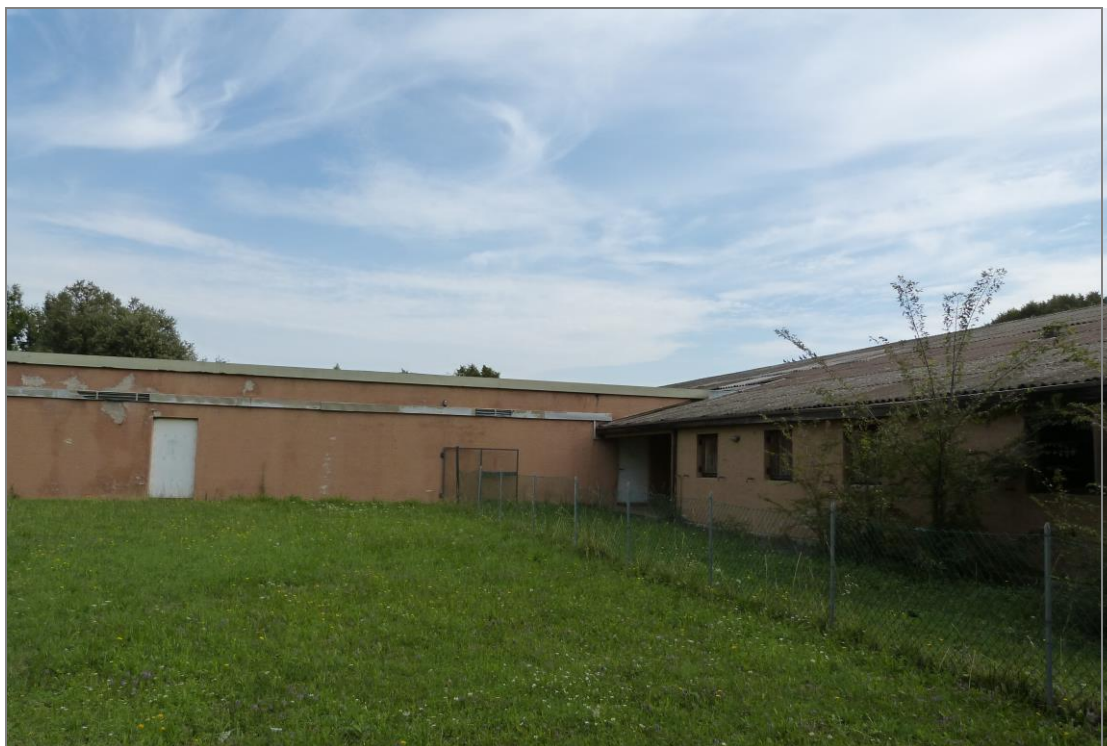
14 Vista di parte del prospetto Ovest dell'abitazione del custode, di parte del prospetto Sud del corpo centrale e di parte dell'area scoperta.
