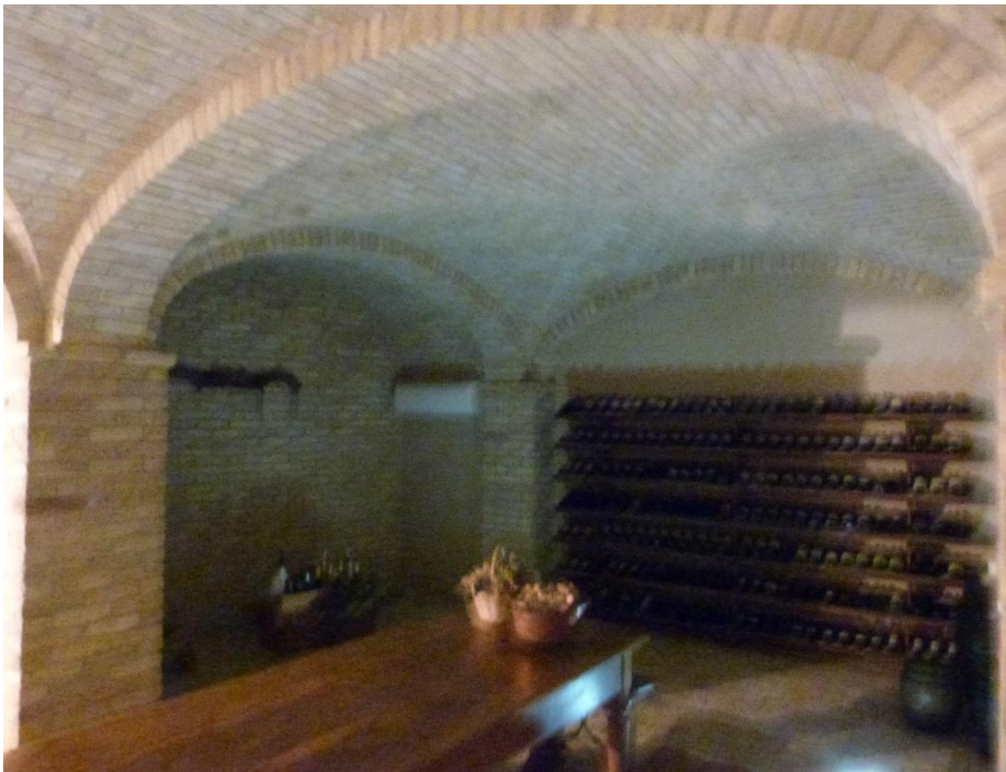
16 Villa-parte interrata: cantina.
