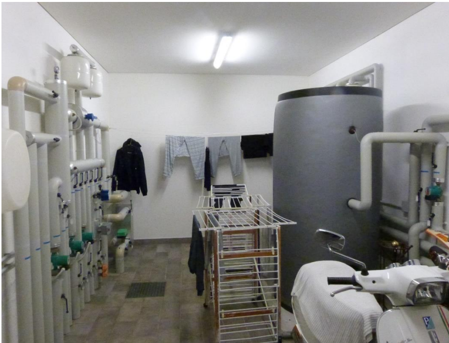
35 Vano tecnico interrato.
