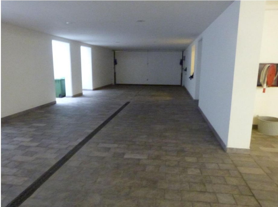
41 Ampliamento interrato – tunnel di accesso al garage.
