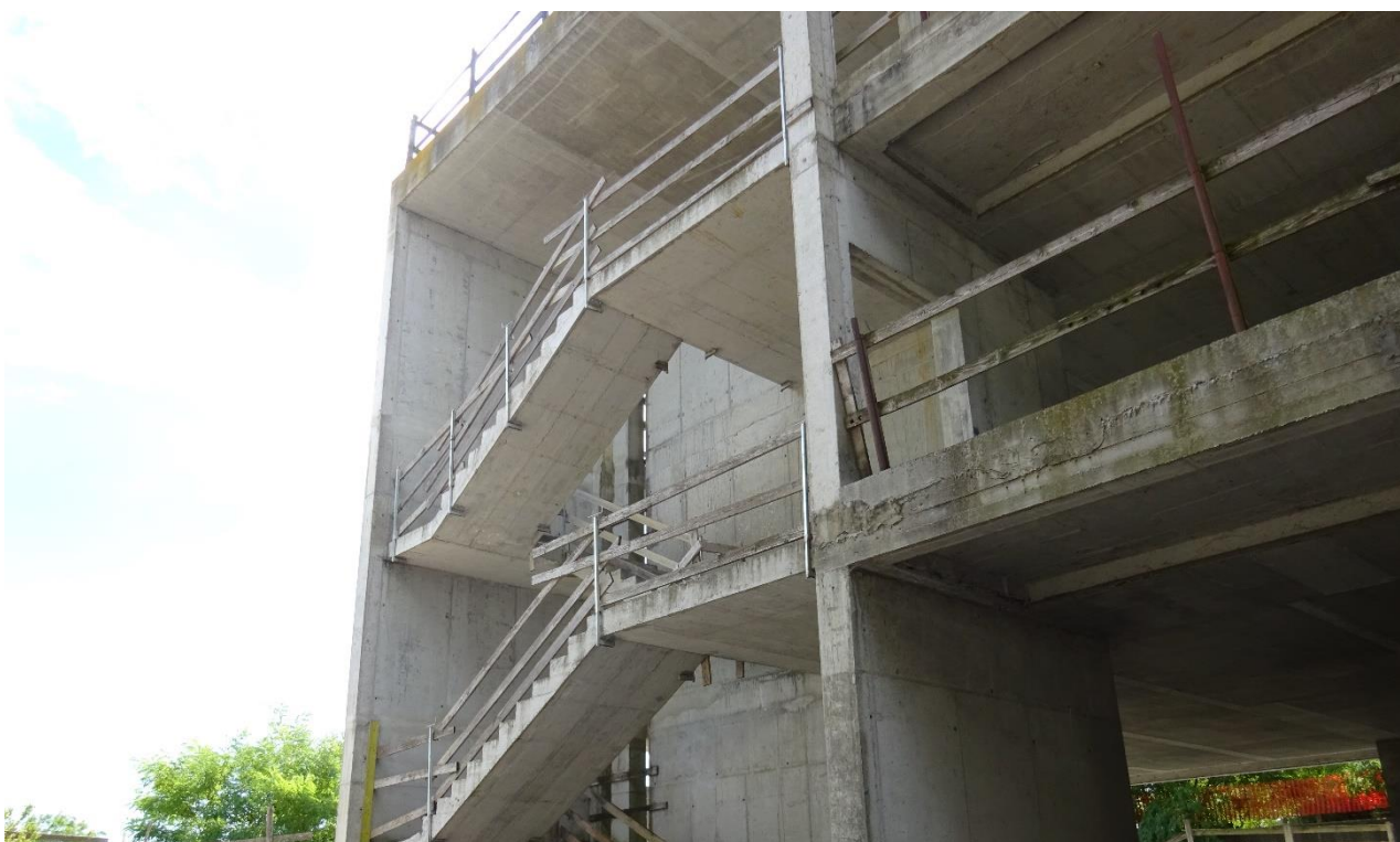
8 Fabbricato al grezzo.
