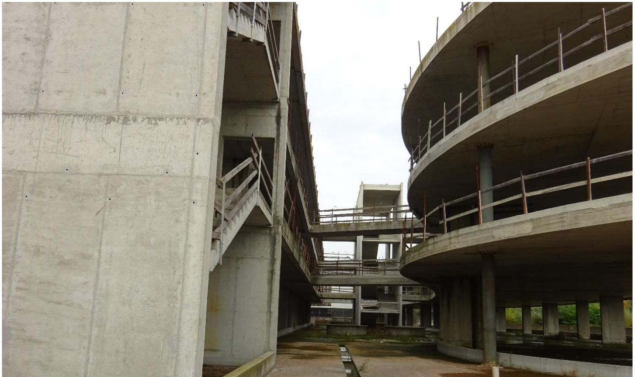
9 Fabbricato al grezzo.
