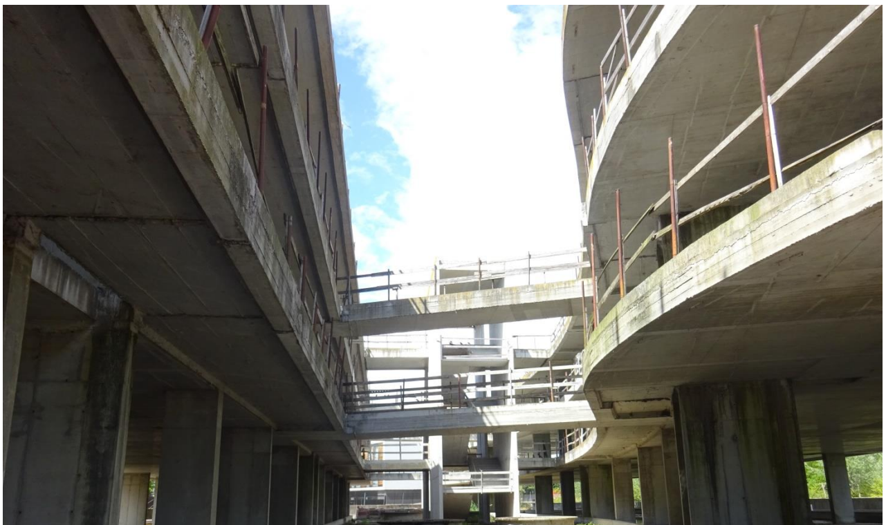
10 Fabbricato al grezzo.
