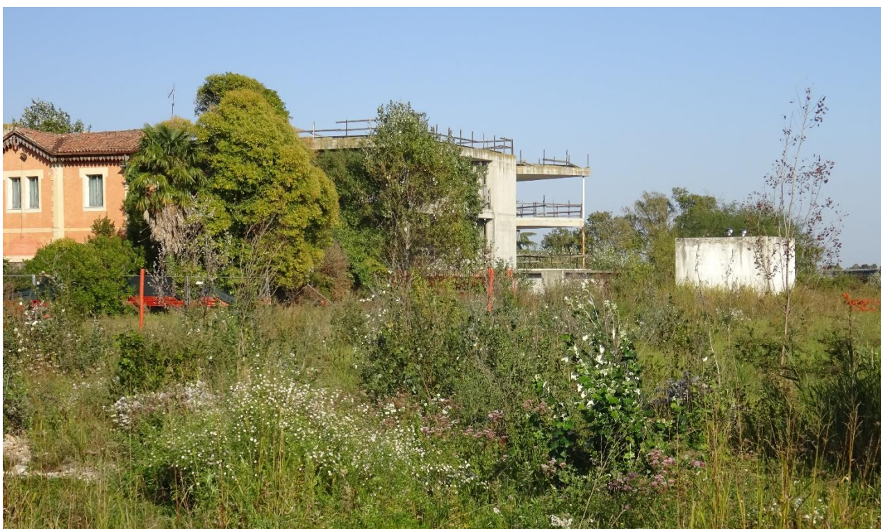
4 Fabbricato destinato a vani tecnici (cabina Enel) e fabbricato al grezzo.
