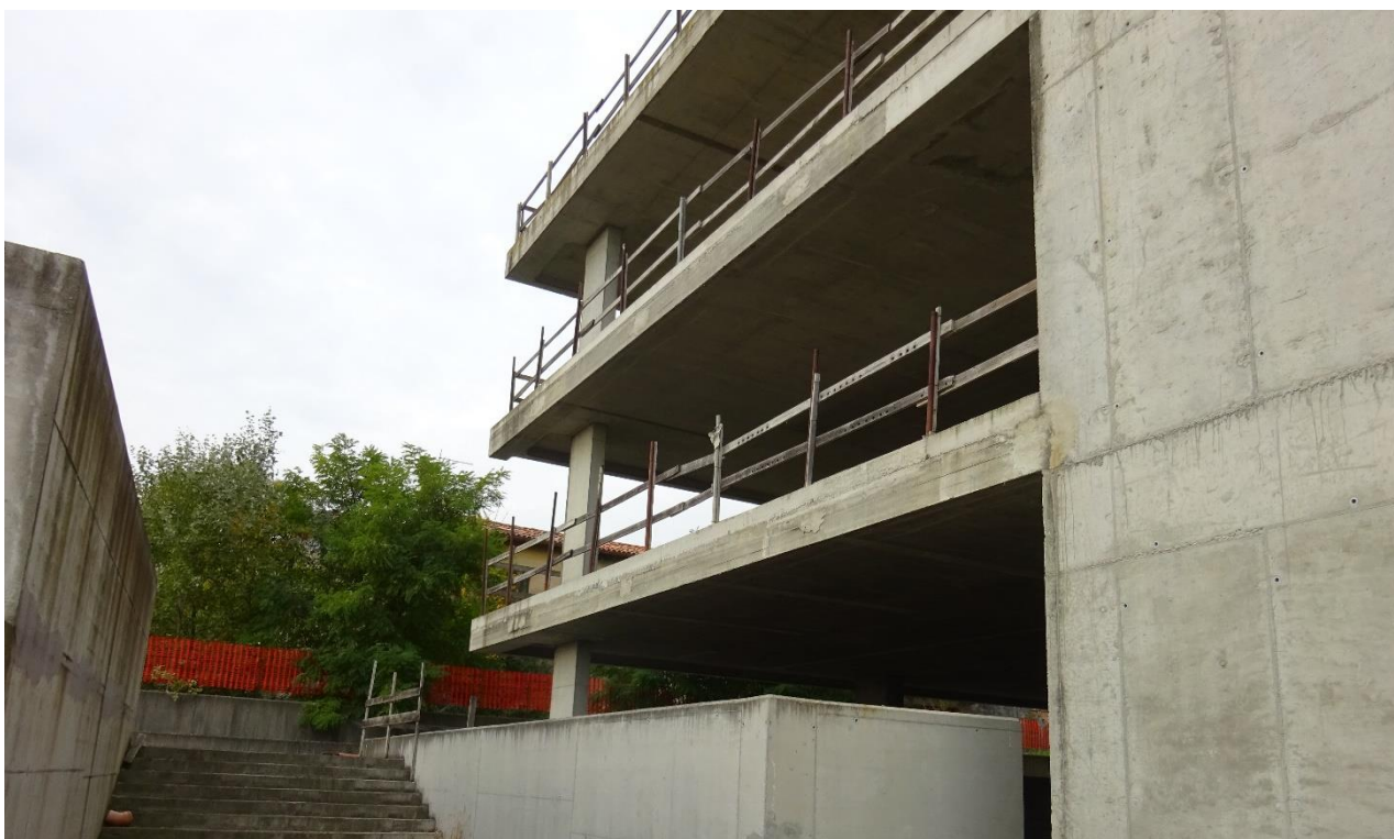
7 Fabbricato al grezzo.
