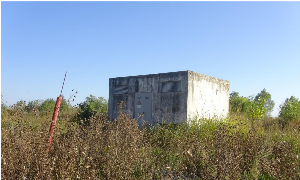
3 Fabbricato destinato a vani tecnici (cabina Enel).
