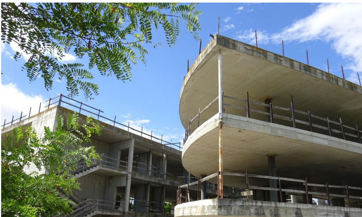
11 Fabbricato al grezzo.
