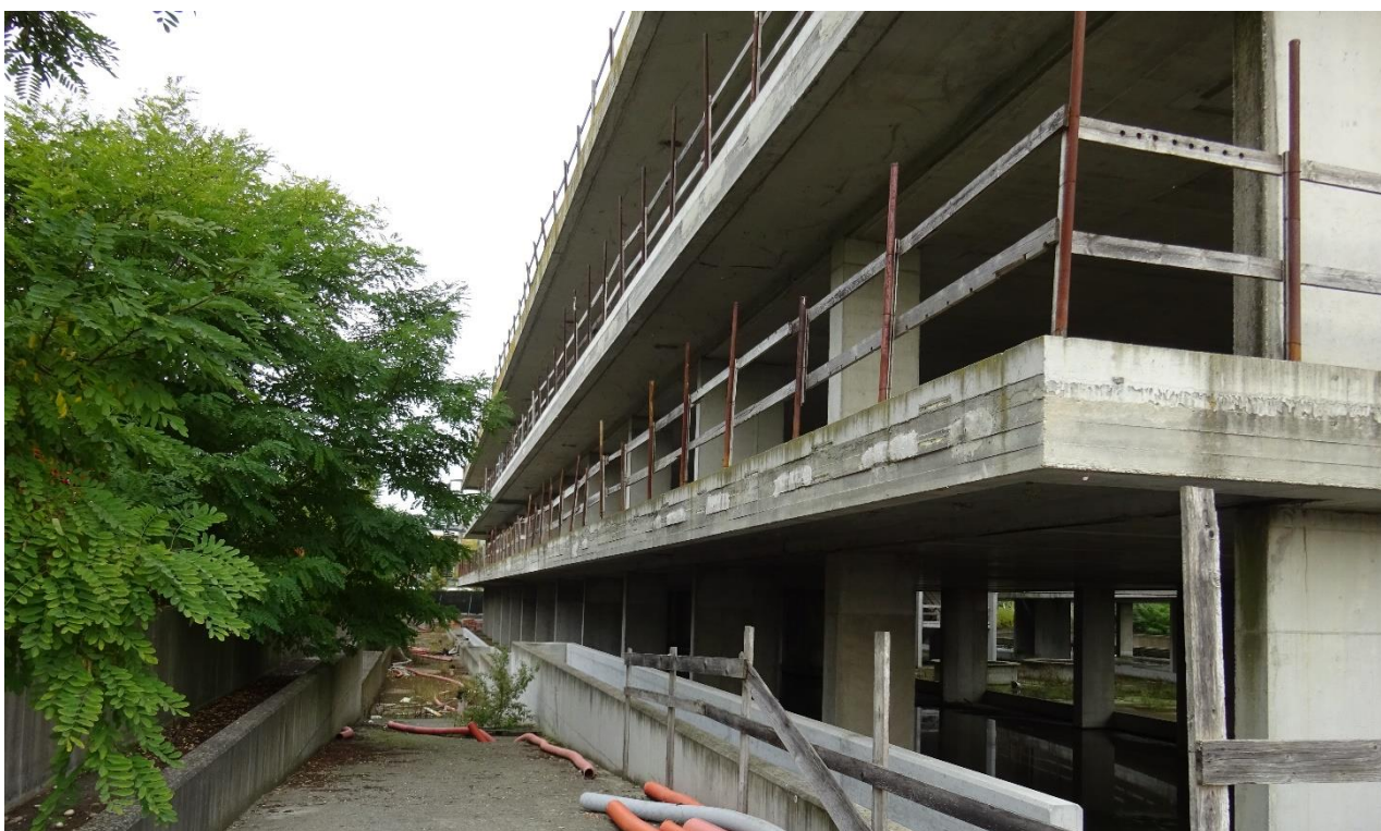
6 Fabbricato al grezzo.
