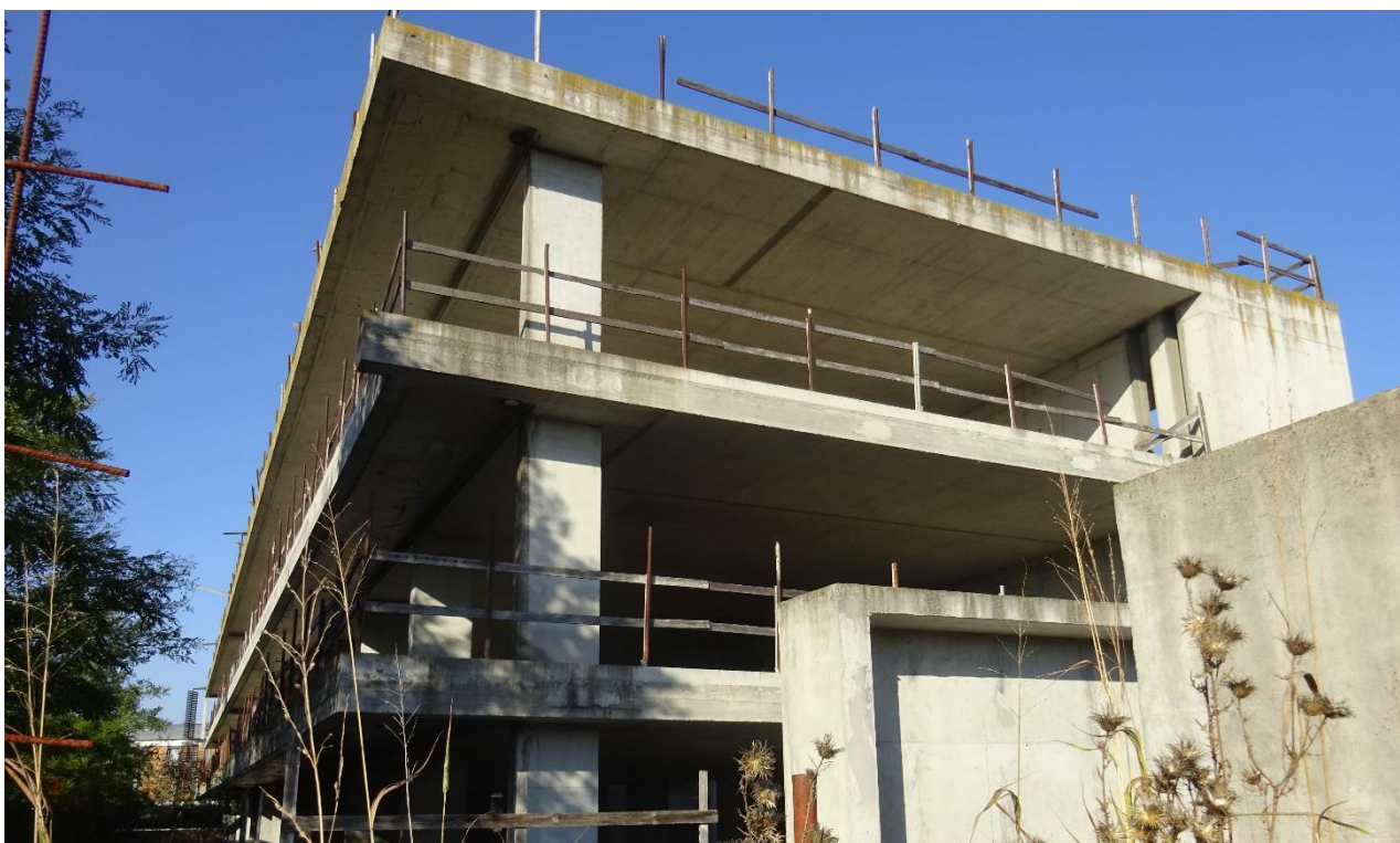
5 Fabbricato al grezzo.
