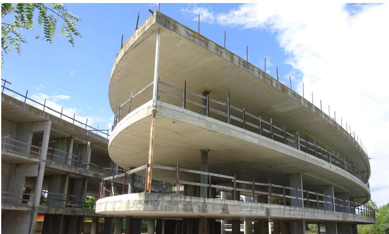
12 Fabbricato al grezzo.
