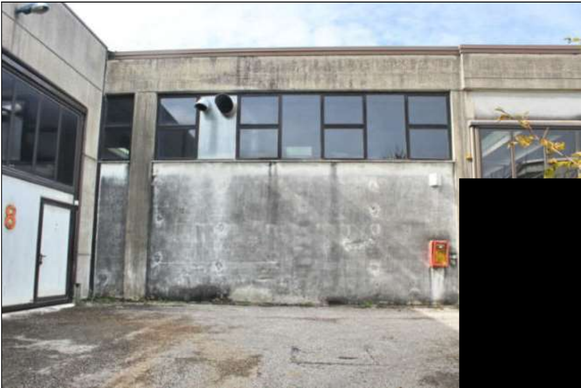
Foto 08 – Fronte est “blocco NORD-OVEST”
