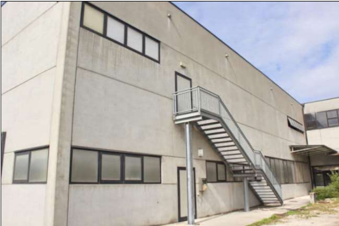
Foto 04 – Fronte est “blocco SUD”
