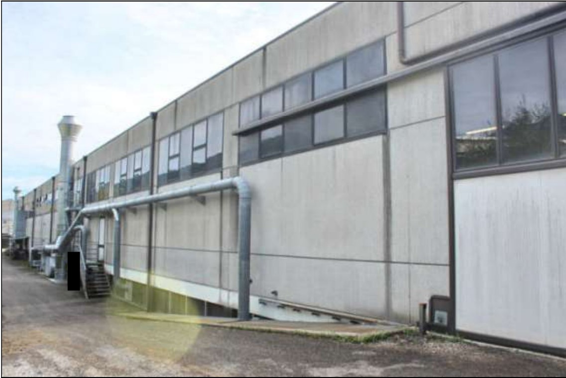
Foto 07 – Fronte nord “blocco NORD-EST”
