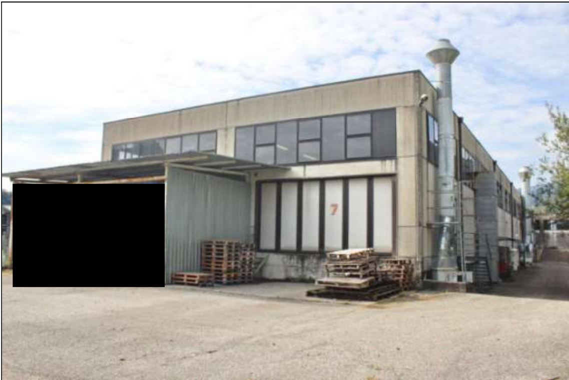
Foto 06 – Fronte est “blocco NORD-EST”
