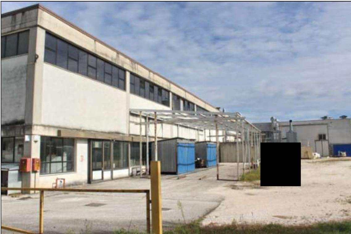
Foto 02 – Fronte sud “blocchi NORD-OVEST e SUD-EST” e fronte ovest “blocco SUD”
