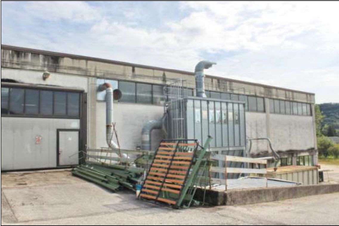
Foto 01 – Fronte ovest “blocco NORD-OVEST”
