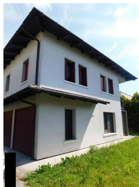
68 - Vista del Prospetto d'angolo sud-ovest
