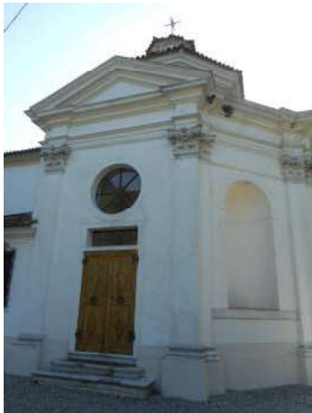
Foto 13 – prospetto ovest oratorio
