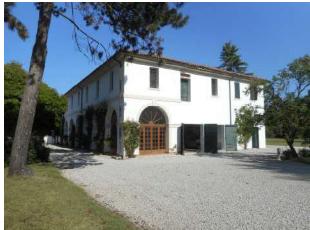
Foto 6 – prospetto est – ingresso garage/magazzino
