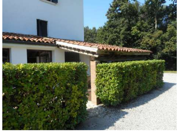
Foto 10 – prospetto nord – tettoia cucina
