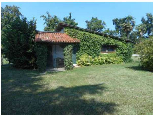
Foto 17 – magazzino corpo staccato (fronte est)
