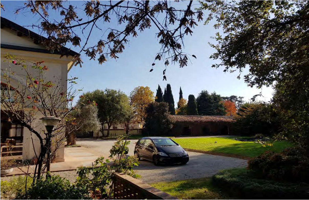
VISTA LATO EST CON AUTORIMESSA
