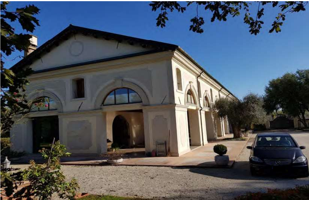
VISTA LATO EST
