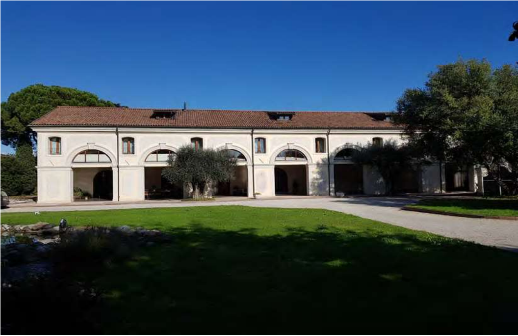
VISTA LATO SUD
