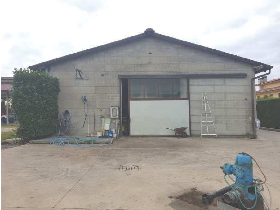
FOTO 5 : vista prospetto esterno lato nord
