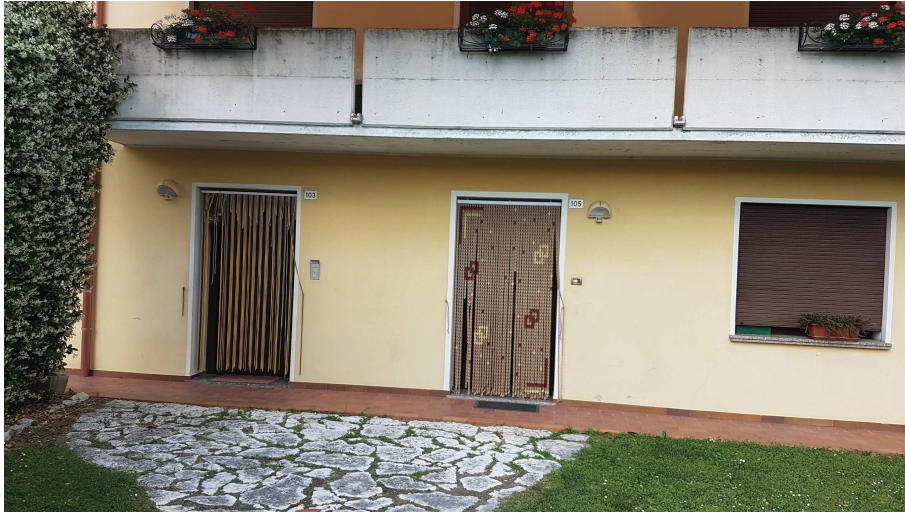
FOTO 35: vista prospetto esterno - entrata
