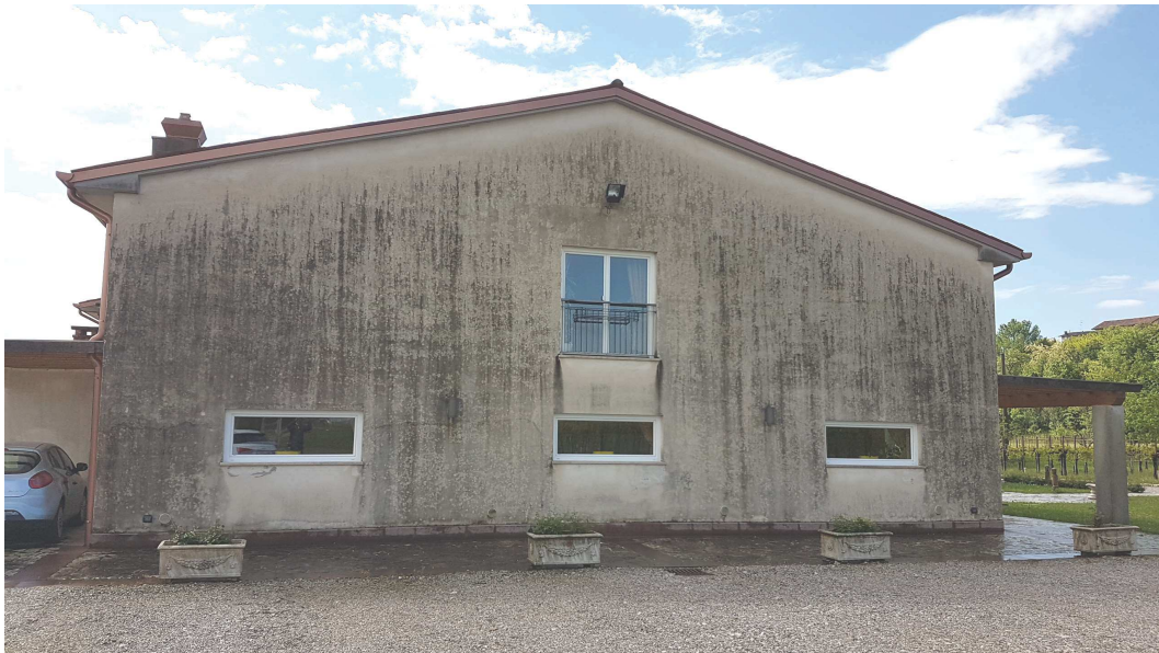
FOTO 2: vista prospetto esterno
