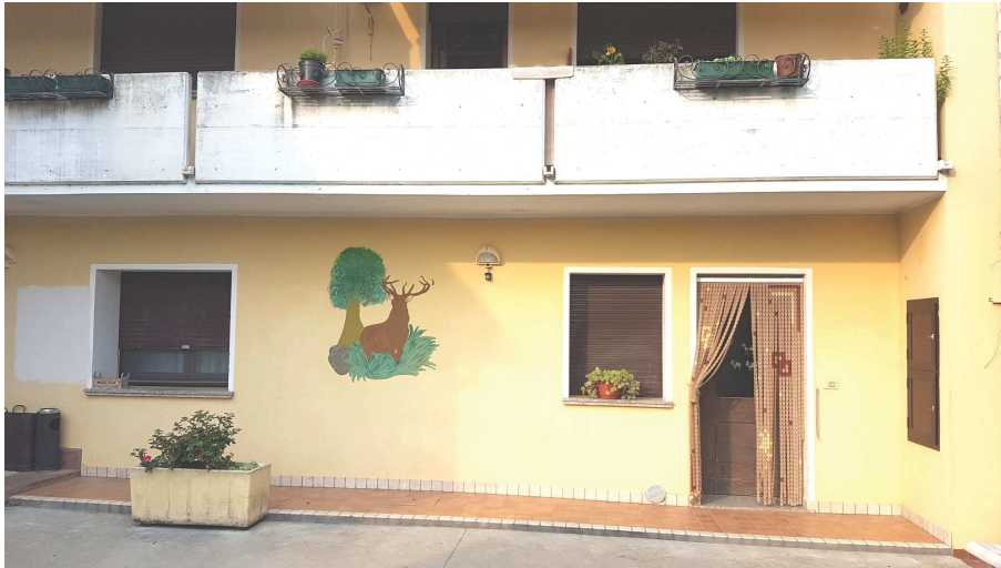
FOTO 30: vista prospetto esterno
