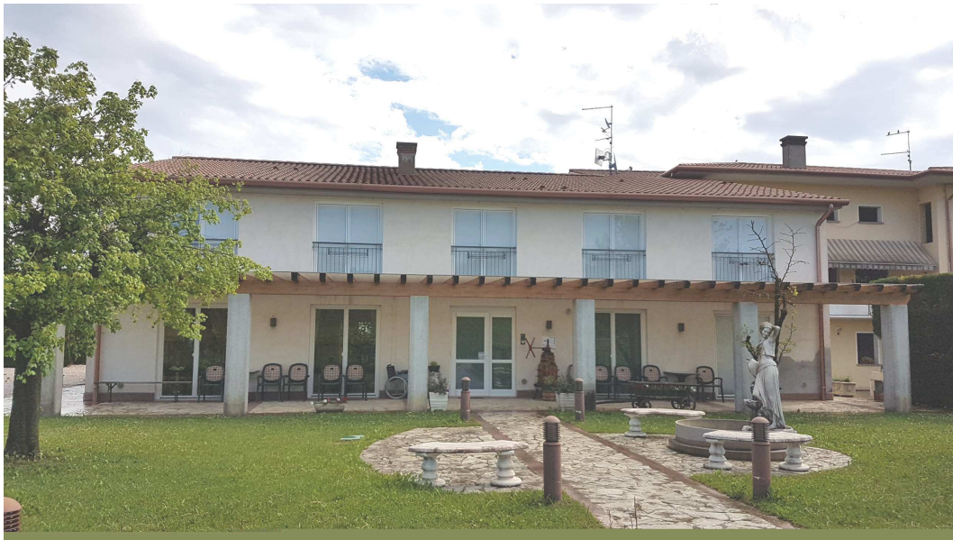
FOTO 1: vista prospetto esterno
