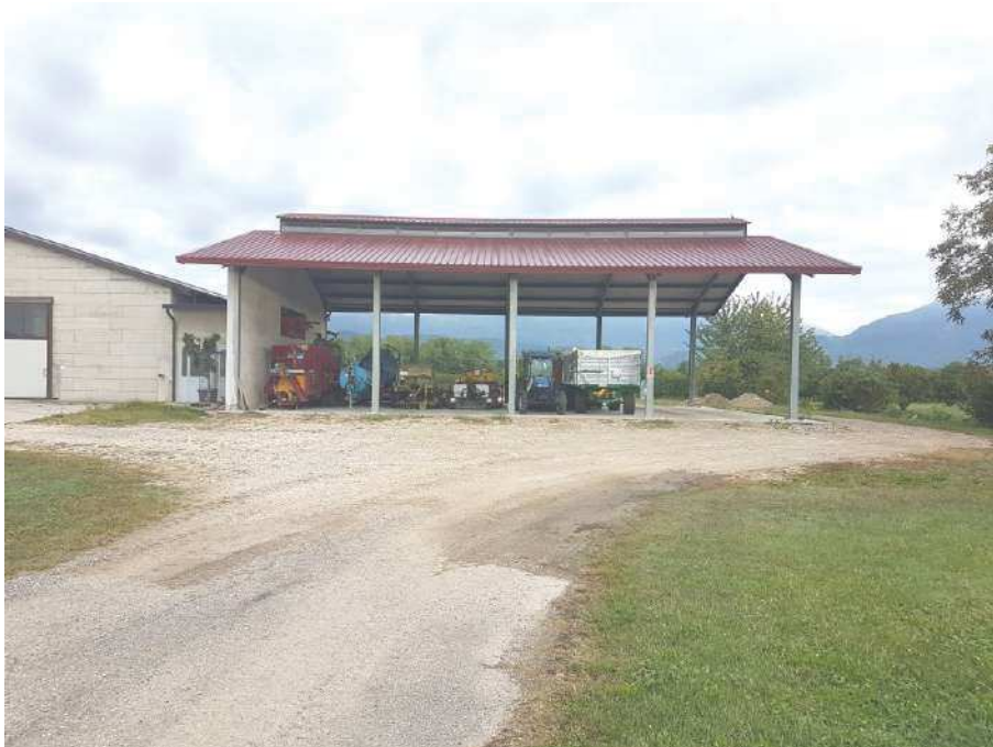
FOTO 2 : vista prospetto esterno lato sud
