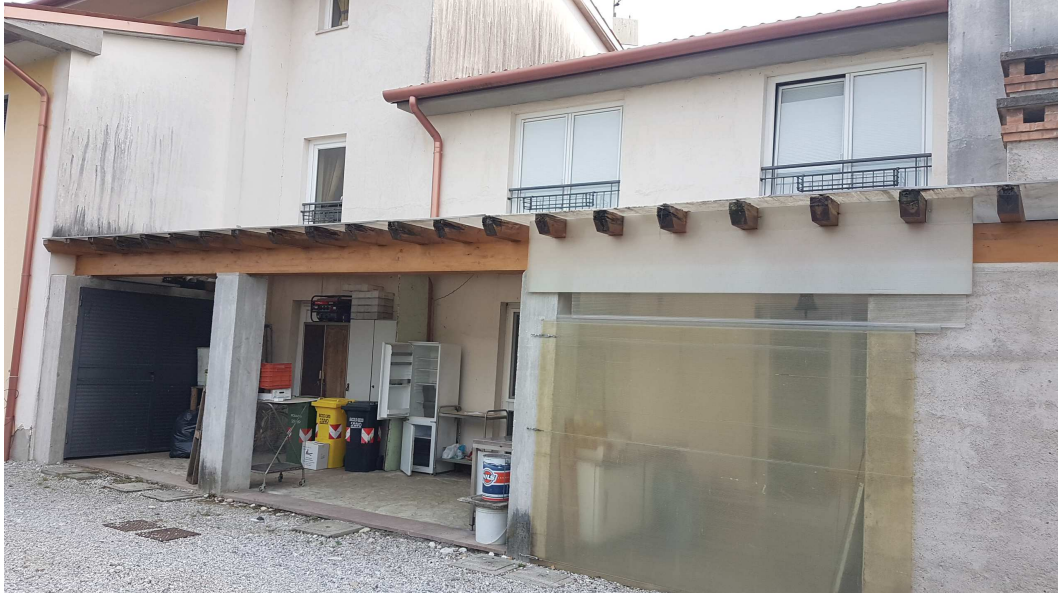
FOTO 3: vista prospetto esterno
