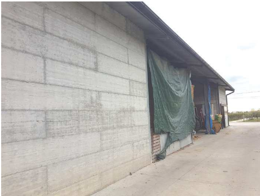
FOTO 6 : prospetto esterno lato nord-ovest
