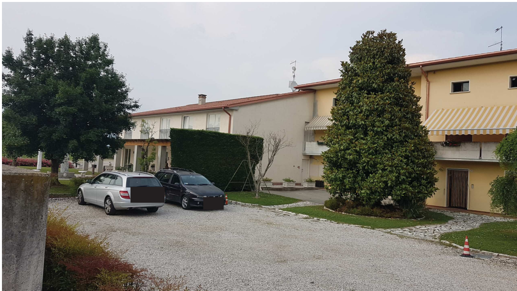
FOTO 4: vista prospetto esterno
