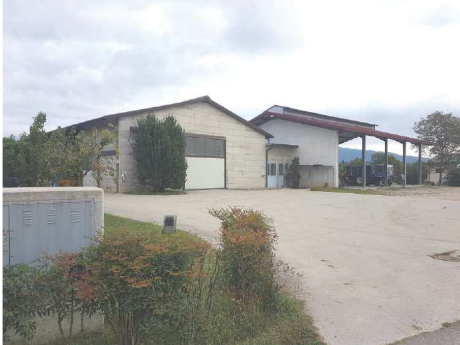
FOTO 1 : vista prospetto esterno lato sud-ovest
