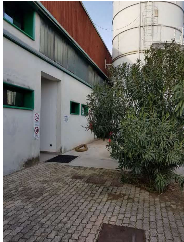
FOTO 5 – INGRESSO SPOGLIATOI LATO EST
