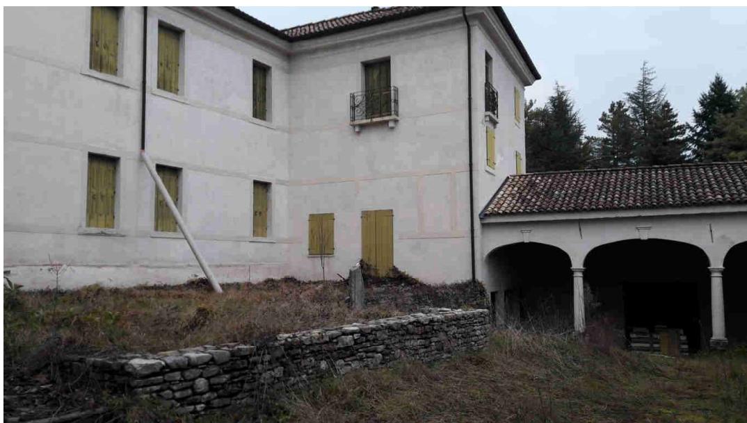
Foto 4 – Vista interna al cortile - Villa vista da Sud/Est
