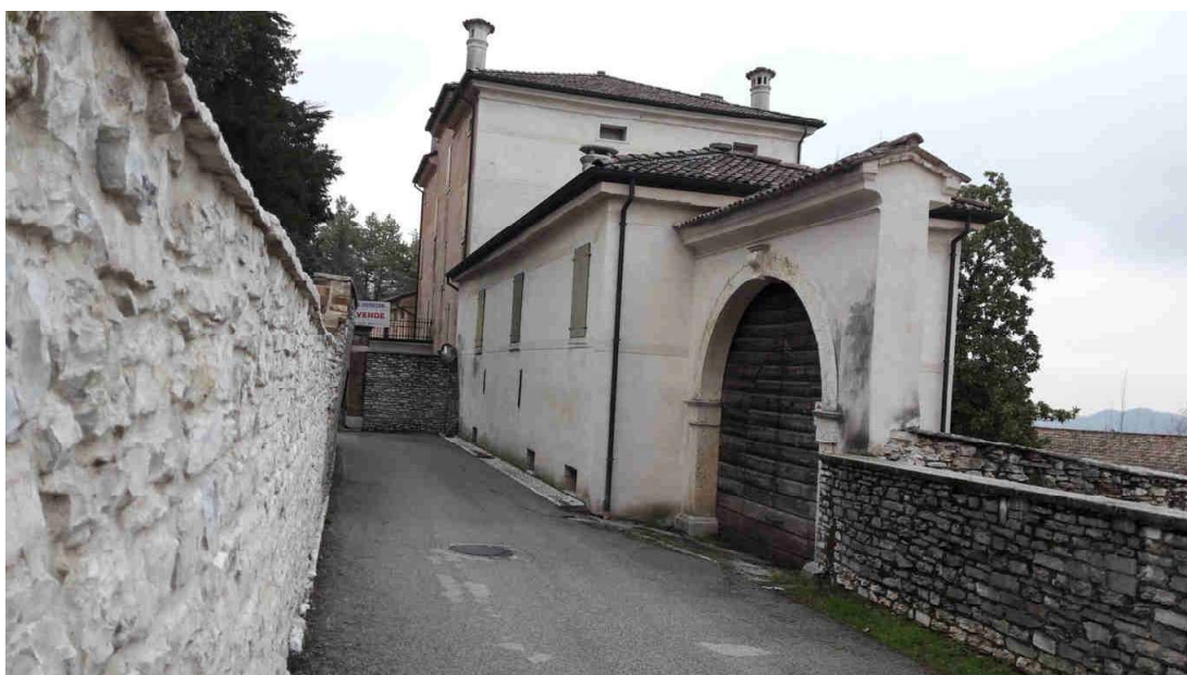
Foto 11 – Ingresso principale da Via Obledo
