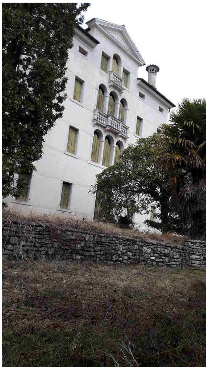
Foto 5 – Villa vista da Sud/Ovest
