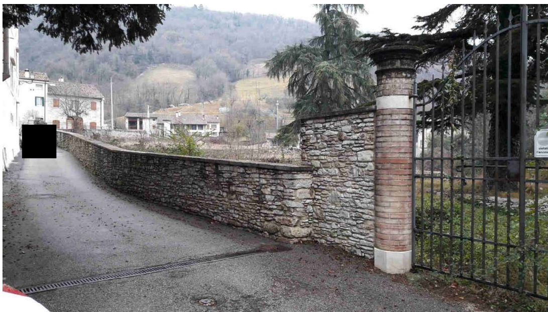
Foto 3 – Vista esterna recinzione lato Ovest
