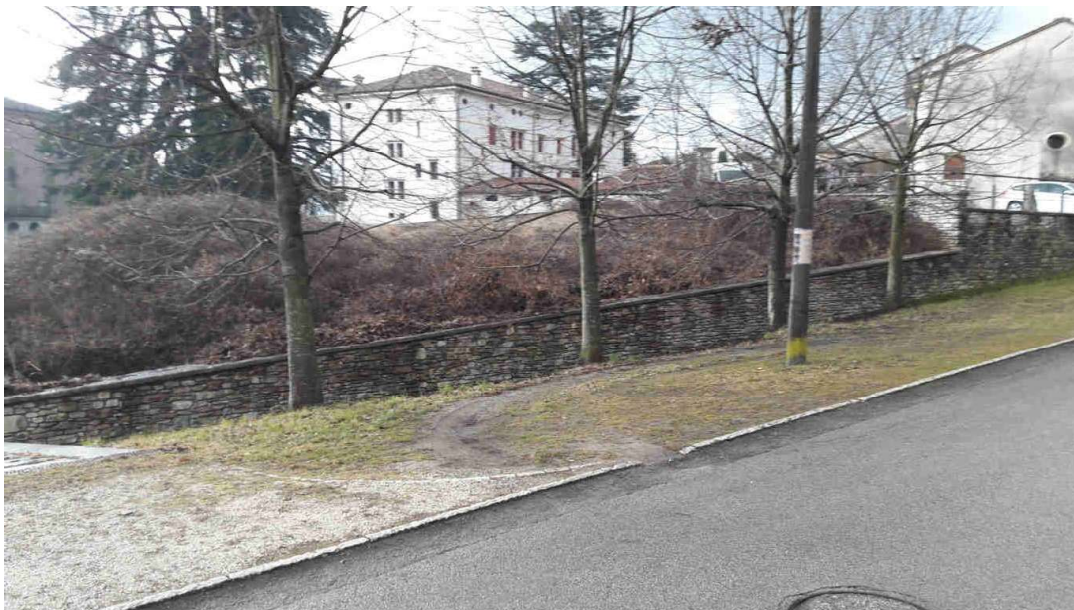
Foto 7 – Vista esterna recinzione lato Nord
