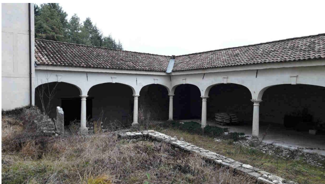
Foto 15 – Vista da nord/ovest interna la cortile chiostro/portico
