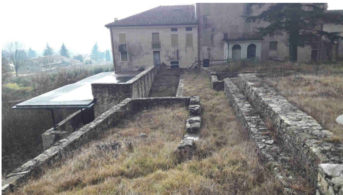
Foto 14 – Vista interna giardino da Nord terrazzamenti
