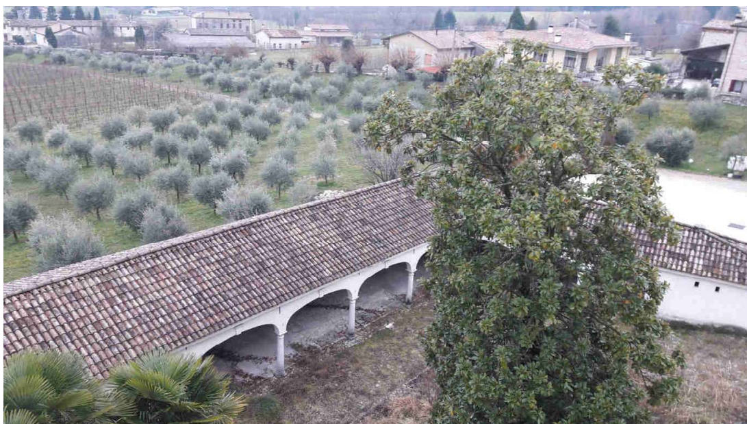
Foto 14 – Vista dal alto cortile e chiostro
