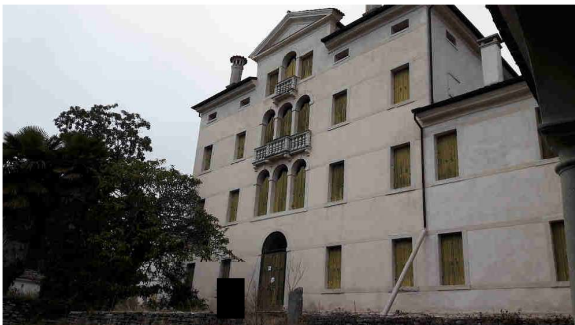
Foto 1 – Vista interna al cortile - Villa vista da Sud/Est
