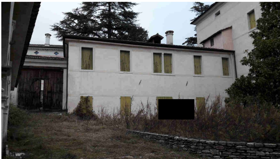
Foto 3 – Vista interna al cortile - Villa vista da Sud/Ovest - particolare portone ingresso
