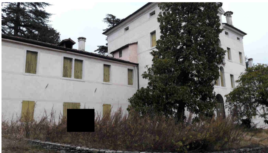
Foto 2 – Vista interna al cortile - Villa vista da Sud/Ovest
