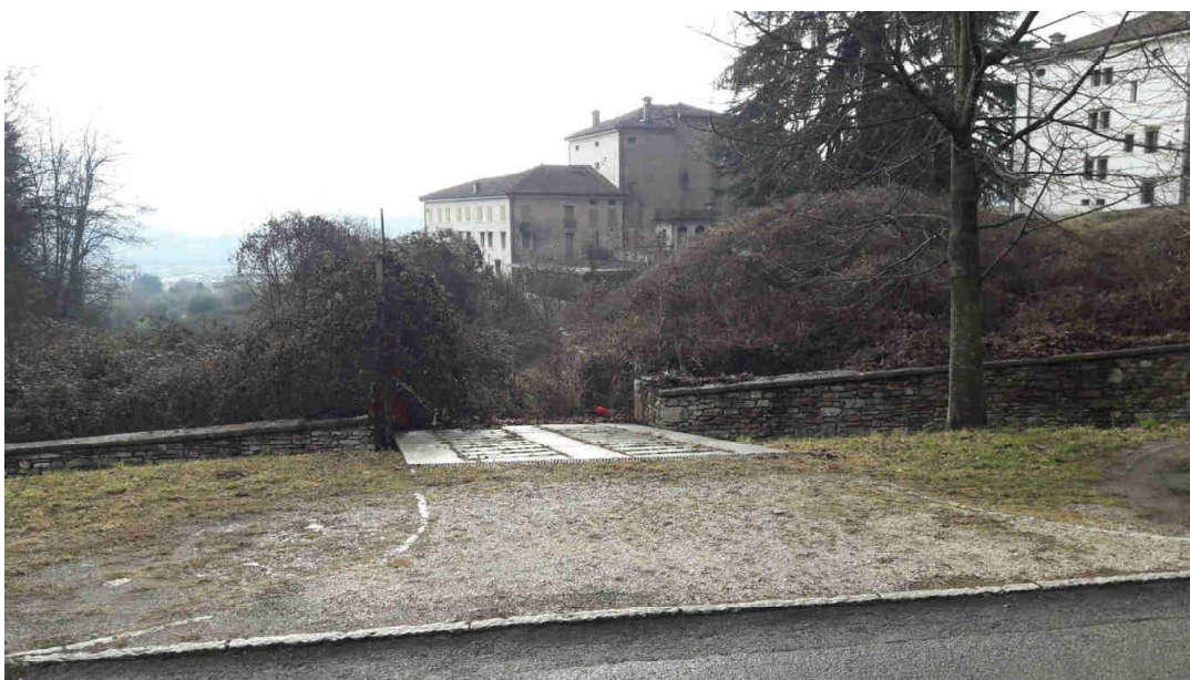
Foto 8 – Vista ingresso carroia recinzione lato Nord
