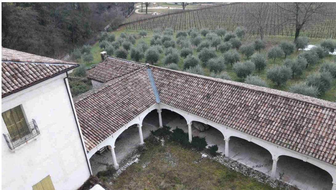
Foto 12 – Vista dal alto cortile e chiostro
