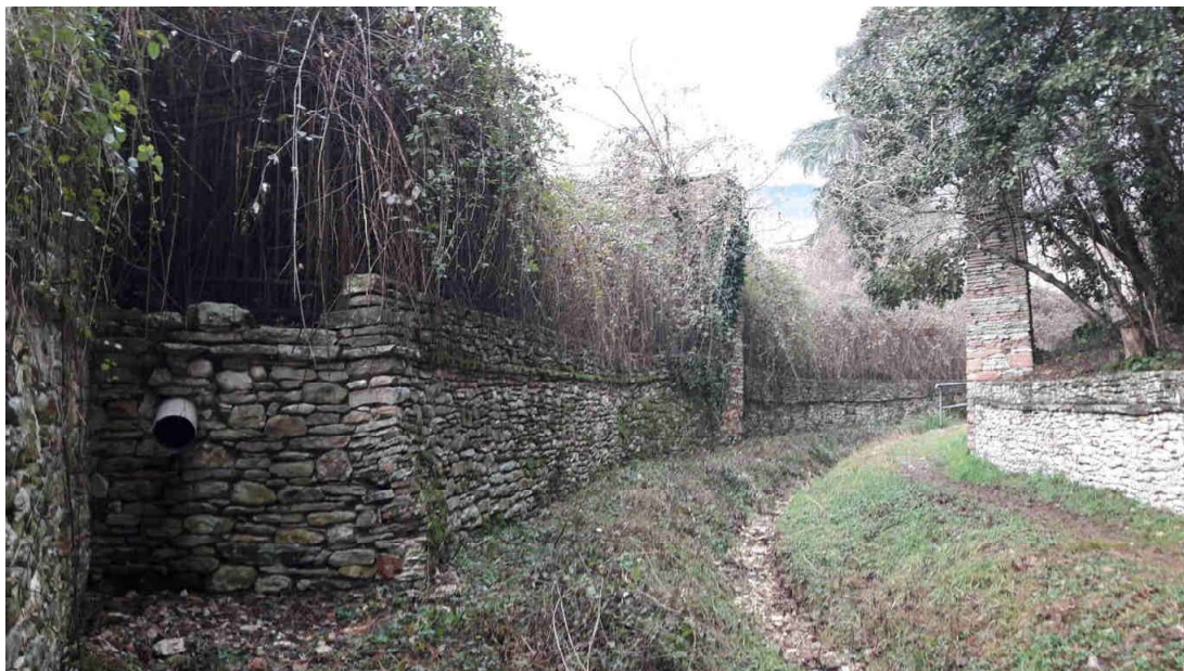
Foto 11 – Vista esterna recinzione lato est -Valle-
