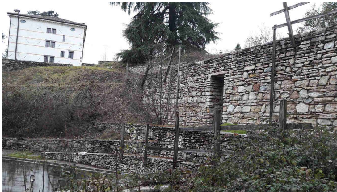
Foto 19 – Vista giardino da Est terrazzamenti , piscina , spogliatoi
