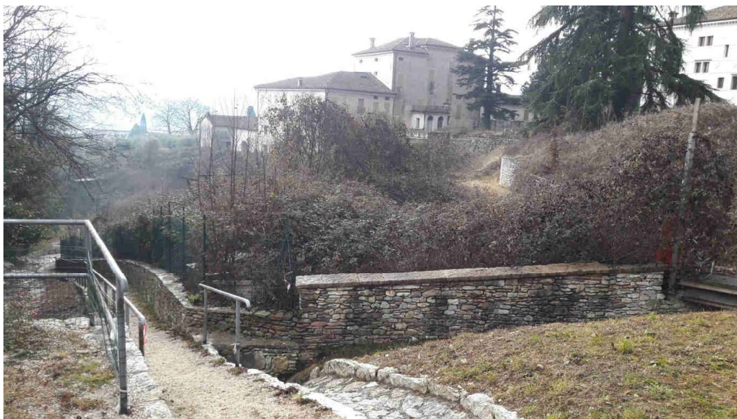
Foto 9 – Vista esterna recinzione lato est -Valle-
