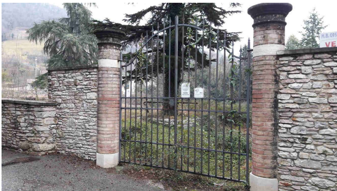
Foto 2 – Vista cancello carraio lato Ovest
