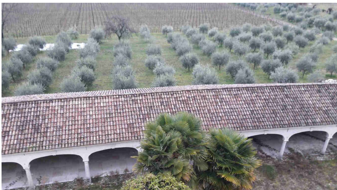
Foto 13 – Vista dal alto cortile e chiostro
