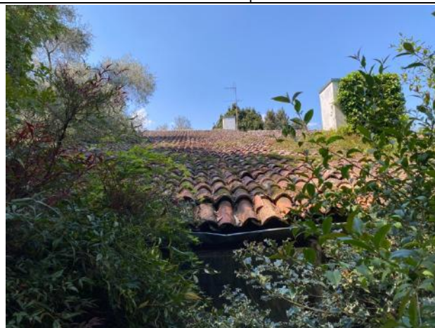
Vista esterna edificio – Copertura Prospetto Sud-Est
