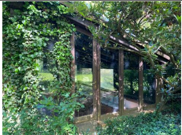
Vista esterna edificio – Prospetto Sud-Est – Veranda chiusa
