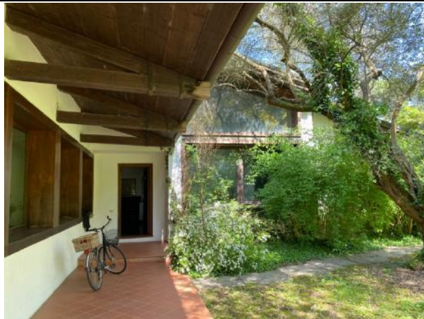
Vista esterna edificio – Prospetto sud - Ingresso
