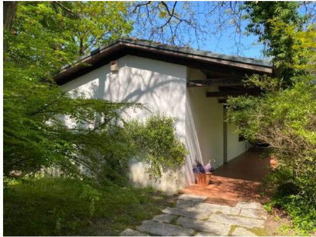
Vista esterna edificio – Prospetto Sud-Ovest
