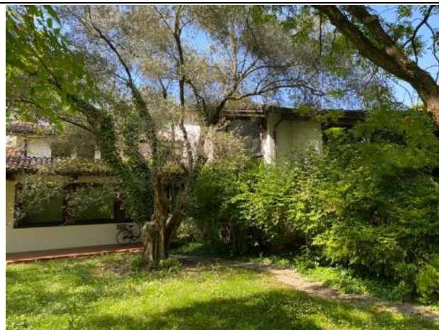
Vista esterna edificio – Prospetto Sud-Est zona ingresso
