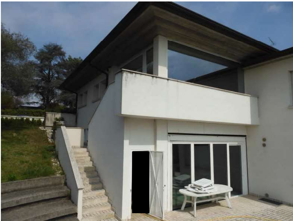
N.6 – Vista ovest (1 di 2)
