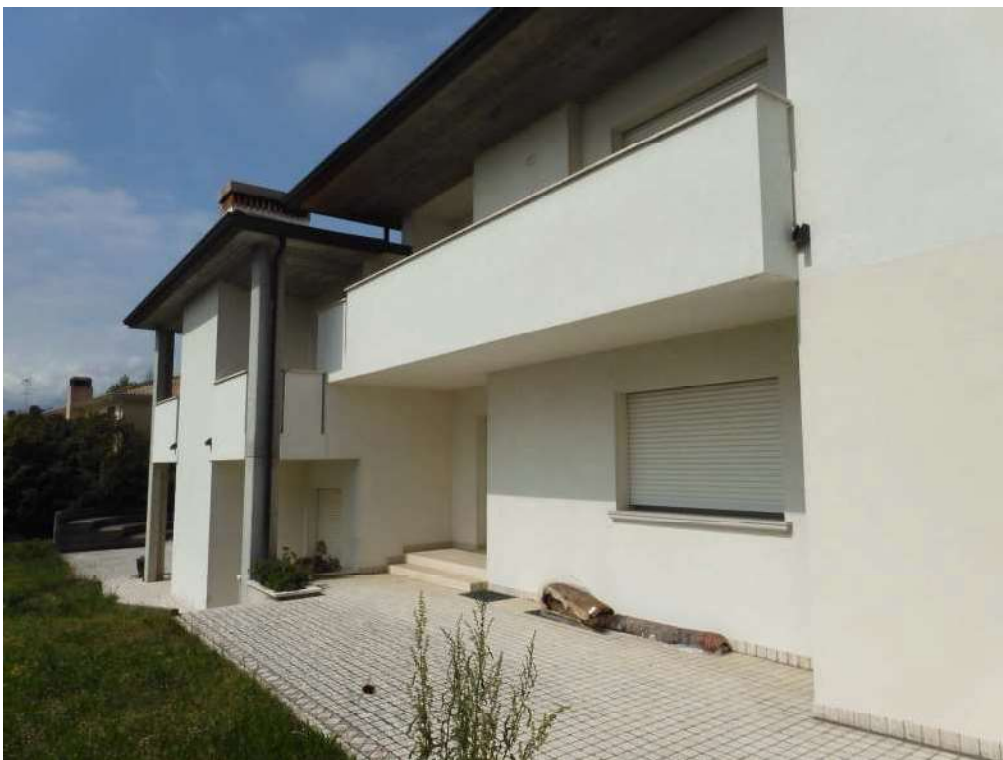
N.4 – Vista sud (1 di 2)
