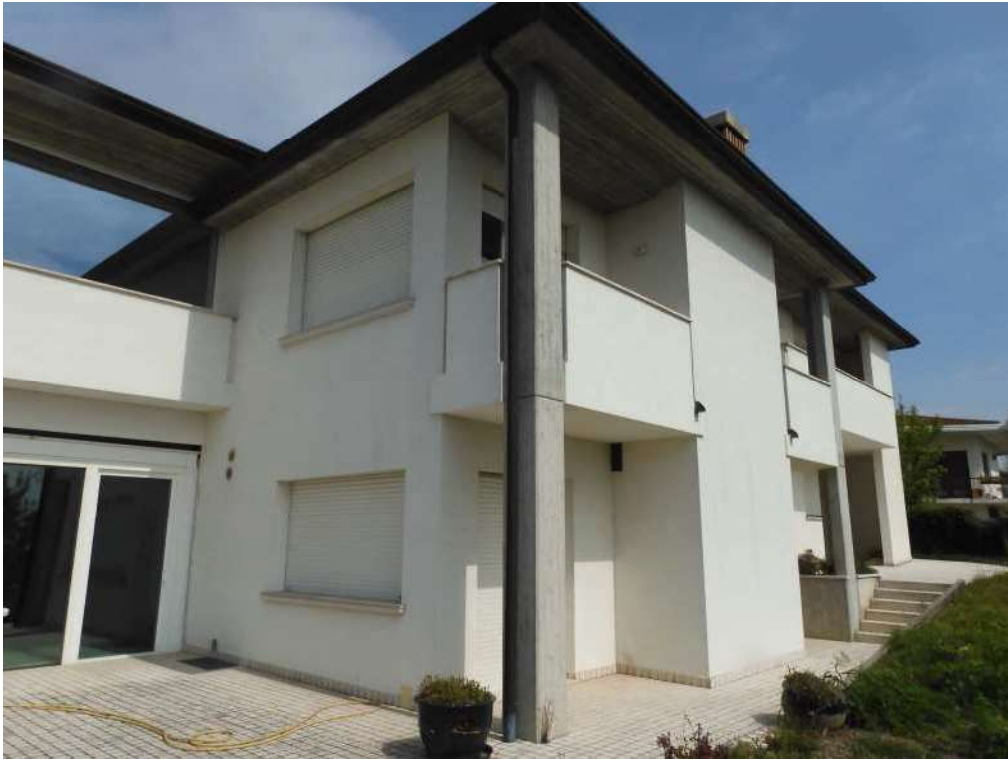
N.5 – Vista sud (2 di 2)
