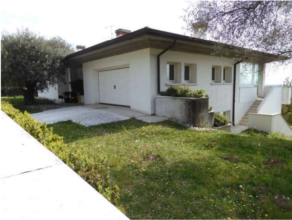
N.7 – Vista ovest (2 di 2)
