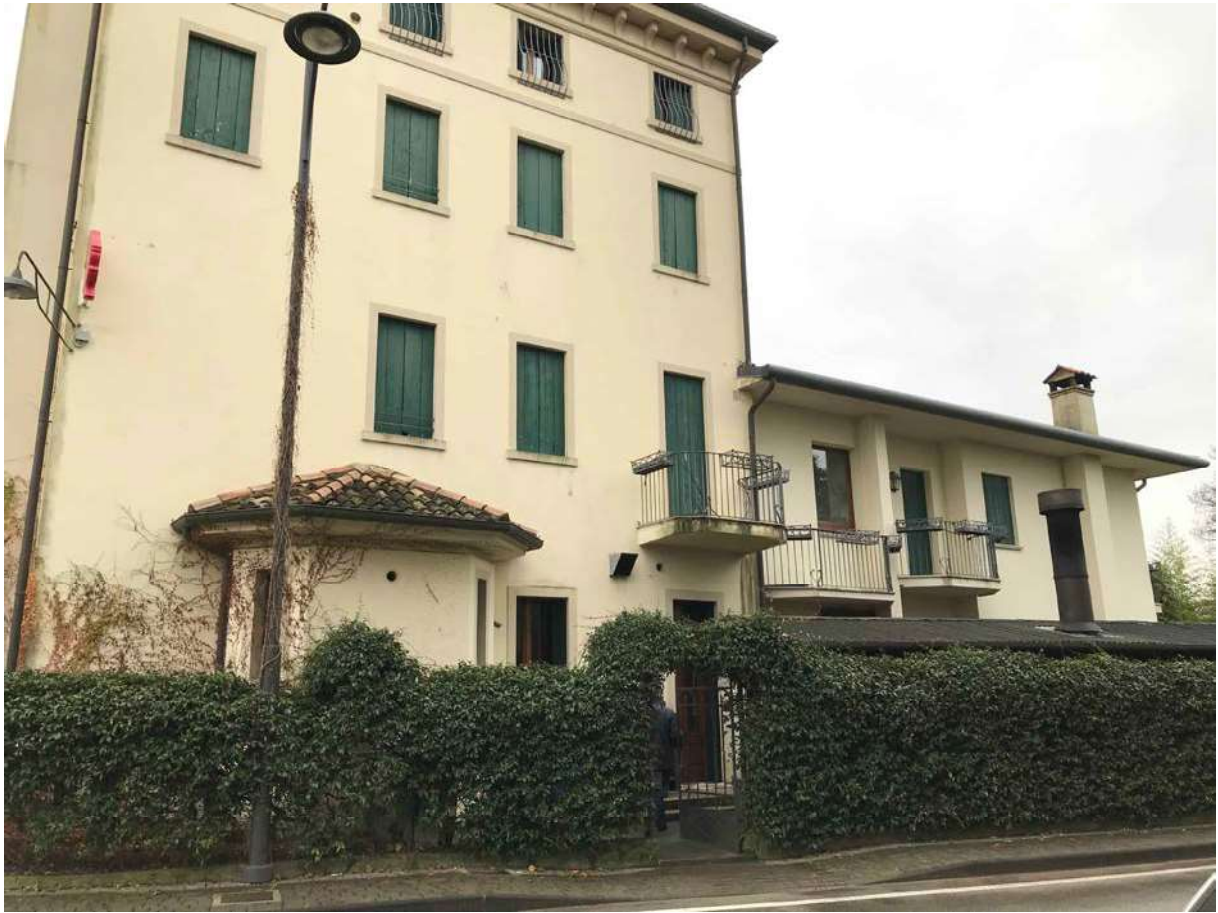
FOTO 10-accesso pedonale lato nord
