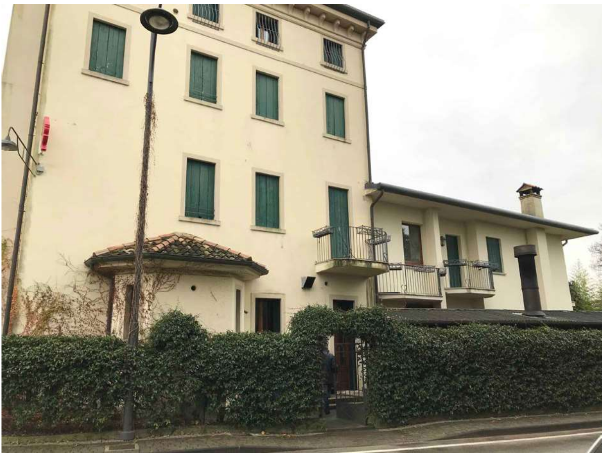
FOTO 3 - accesso pedonale lato nord
