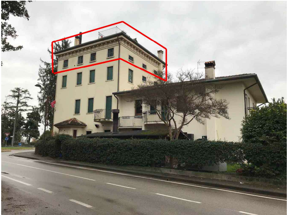
FOTO 2 - vista dal nord
