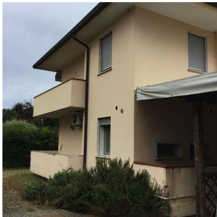
Prospetto Sud dell'edificio
