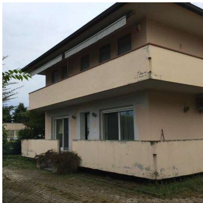
Prospetto Ovest dell'edificio
